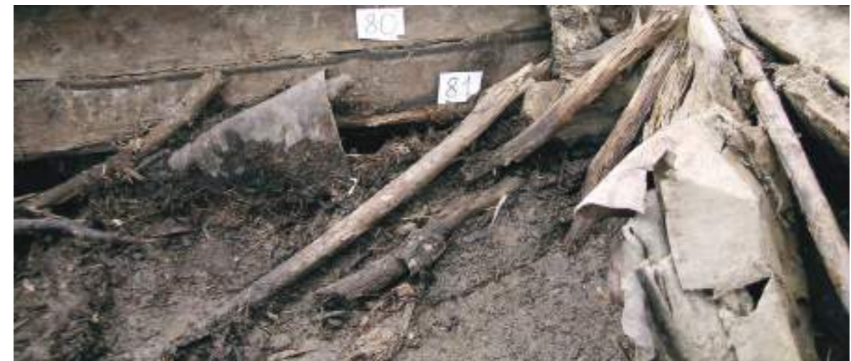
Рис. 2.57. Полуийский мысовой городок. Прилегающее поселение-посад (раскоп № 1, 2, 2004 г.). Постройка № 3, участок К'-Л'/42. Детали: берестяные листы в конструкция кровли выполнявшие функции гидроизоляции, уровень третьей фиксации: 20.80-21.20. Строение периода функционирования конца XVI - пер. трети XVIII вв.
