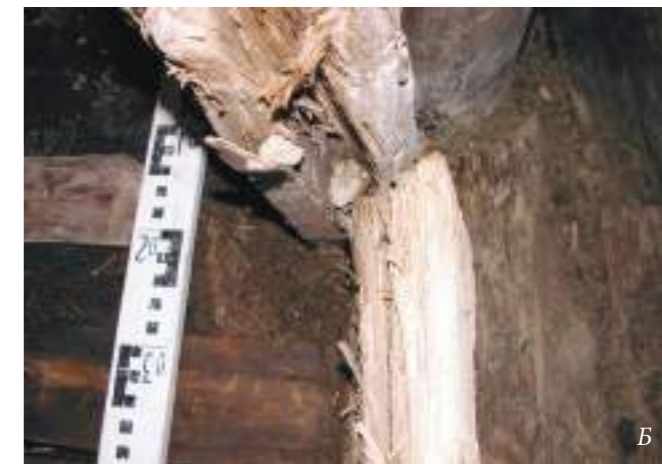
Рис. 2.19. (А, Б). Полуийский мысовой городок. Оборонительно-жилой комплекс (раскоп № 5, 2004 г.). Постройка № 1, участок Ш/25– 26. Перегородка центрального помещения с отверстиями и остатками нагелей – доски бортового набора судна типа дощаника или барки: А – сопряжение с опорным столбом центрального помещения, вид с СЗ из пространства галереи; Б – сопряжение с опорным столбом центрального помещения, вид с верху. Строительный горизонт последнего периода реконструкции 1660–70-х гг.
