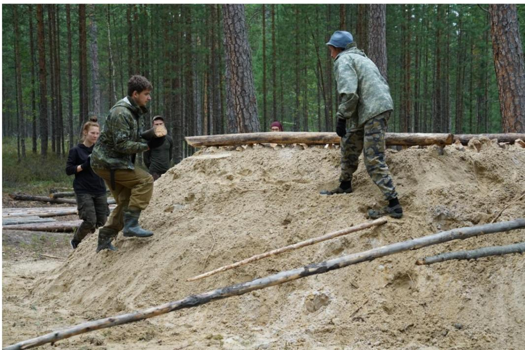
Рис.2.39. В рамках реализации проекта «Архитектура древней Югры», поддержанного Фондом президентских грантов, производилось воссоздание фрагмента укрепленного поселения начала VI тыс. до н.э. Каюково 2. Монтаж кровли, укладка дернового гнета.
