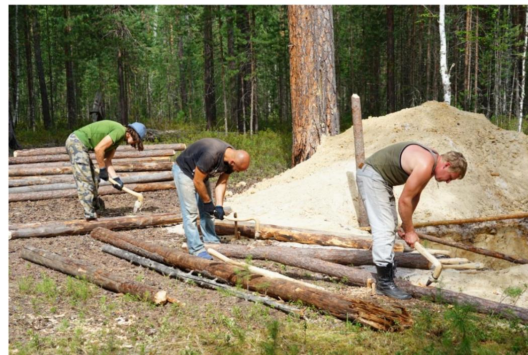
Рис.2.15. В рамках реализации проекта «Архитектура древней Югры», поддержанного Фондом президентских грантов, производилось воссоздание фрагмента укрепленного поселения начала VI тыс. до н.э. Каюково 2. Рубка деталей постройки аутентичными инструментами.
