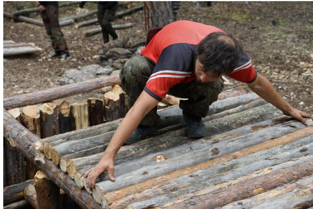
Рис.2.37. В рамках реализации проекта «Архитектура древней Югры», поддержанного Фондом президентских грантов, производилось воссоздание фрагмента укрепленного поселения начала VI тыс. до н.э. Каюково 2. Монтаж кровли.
