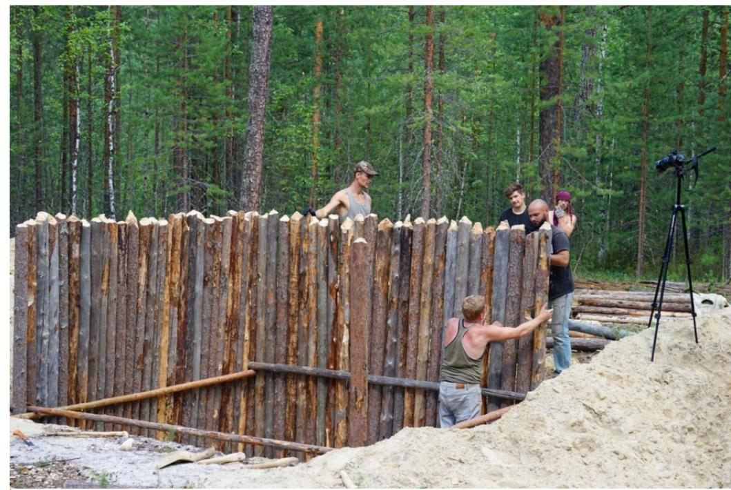
Рис.2.31. В рамках реализации проекта «Архитектура древней Югры», поддержанного Фондом президентских грантов, производилось воссоздание фрагмента укрепленного поселения начала VI тыс. до н.э. Каюково 2. Монтаж стен жилища.
