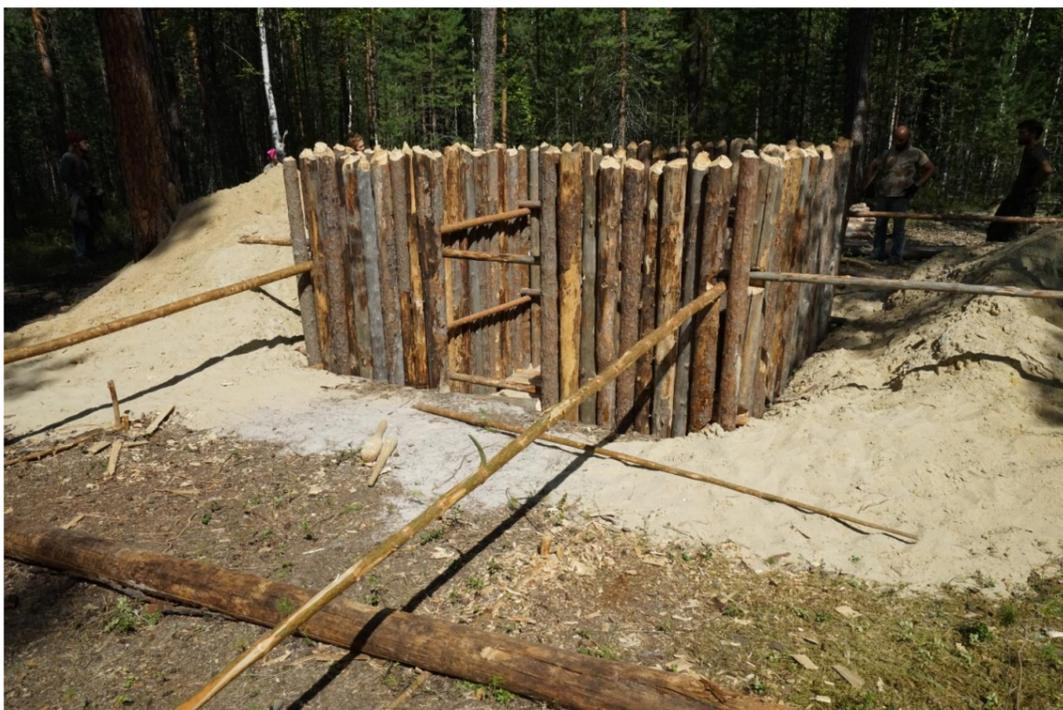
Рис.2.34. В рамках реализации проекта «Архитектура древней Югры», поддержанного Фондом президентских грантов, производилось воссоздание фрагмента укрепленного поселения начала VI тыс. до н.э. Каюково 2. Жилище на этапе завершения монтажа стен.
