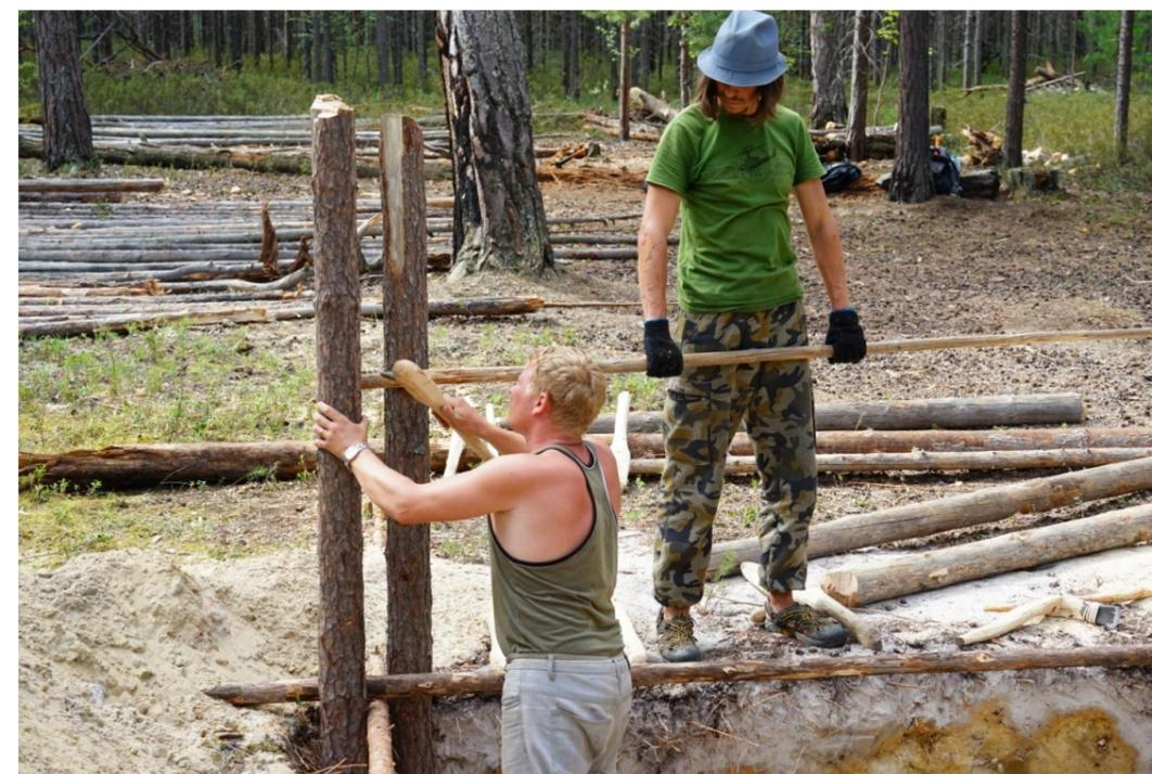
Рис.2.29. В рамках реализации проекта «Архитектура древней Югры», поддержанного Фондом президентских грантов, производилось воссоздание фрагмента укрепленного поселения начала VI тыс. до н.э. Каюково 2. Начало монтажа стен жилища.
