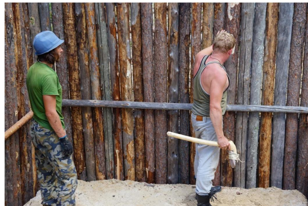
Рис.2.33. В рамках реализации проекта «Архитектура древней Югры», поддержанного Фондом президентских грантов, производилось воссоздание фрагмента укрепленного поселения начала VI тыс. до н.э. Каюково 2. Монтаж стен жилища.
