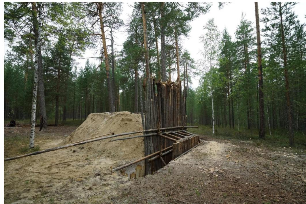
Рис.2.58. В рамках реализации проекта «Архитектура древней Югры», поддержанного Фондом президентских грантов, производилось воссоздание фрагмента укрепленного поселения начала VI тыс. до н.э. Каюково 2. Готовый фрагмент оборонительной стены. Общий вид.
