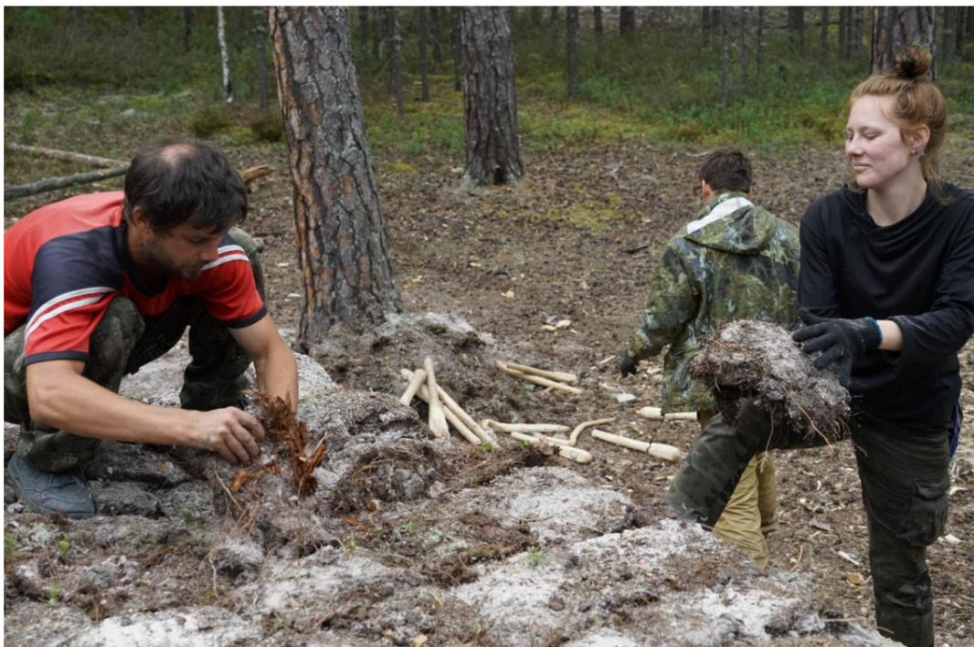
Рис.2.41. В рамках реализации проекта «Архитектура древней Югры», поддержанного Фондом президентских грантов, производилось воссоздание фрагмента укрепленного поселения начала VI тыс. до н.э. Каюково 2. Монтаж кровли, укладка дернового гнета.
