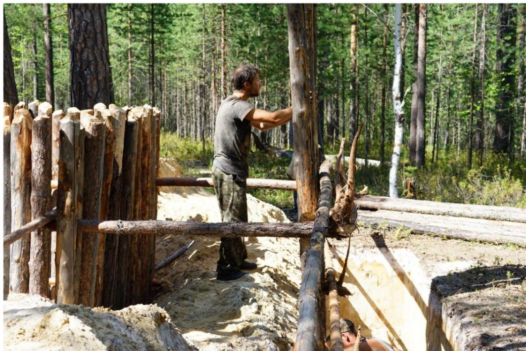
Рис.2.51. В рамках реализации проекта «Архитектура древней Югры», поддержанного Фондом президентских грантов, производилось воссоздание фрагмента укрепленного поселения начала VI тыс. до н.э. Каюково 2. Монтаж фрагмента оборонительной стены.
