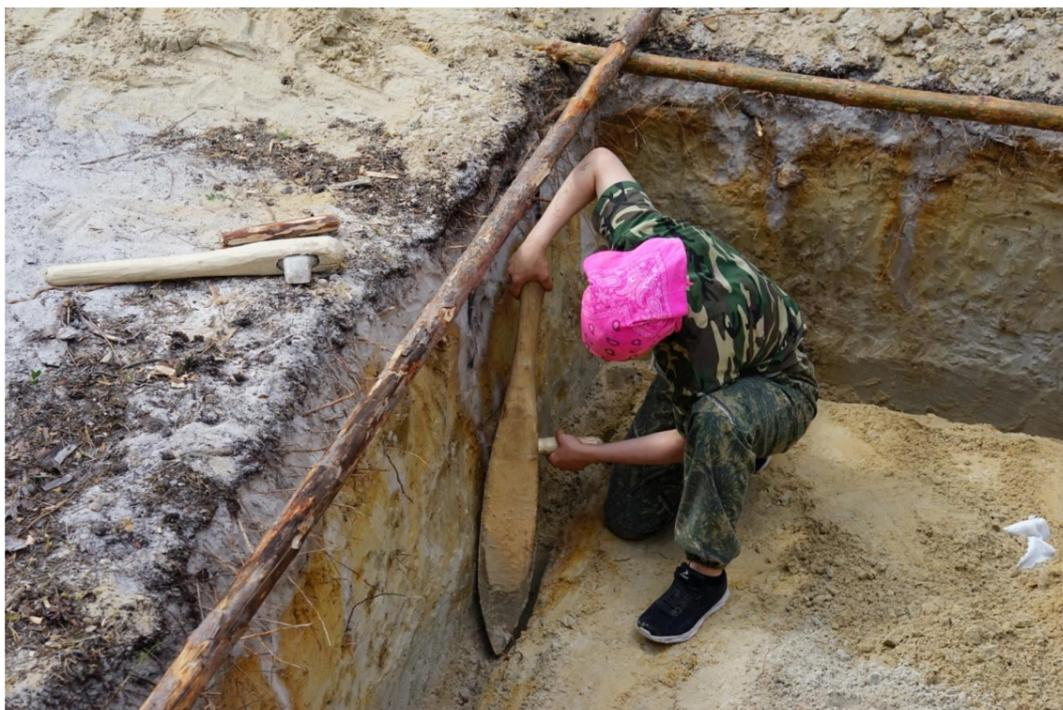
Рис.2.26. В рамках реализации проекта «Архитектура древней Югры», поддержанного Фондом президентских грантов, производилось воссоздание фрагмента укрепленного поселения начала VI тыс. до н.э. Каюково 2. Выкапывание траншей для фиксации основания стен.
