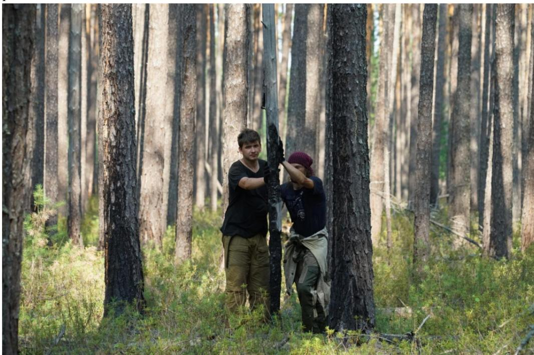
Рис. 2.7. В рамках реализации проекта «Архитектура древней Югры», поддержанного Фондом президентских грантов, производилось воссоздание фрагмента укрепленного поселения начала VI тыс. до н.э. Каюково 2. Заготовка строительного материала (сухостоя).
