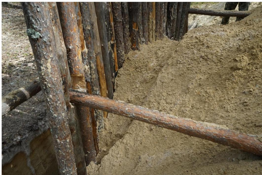
Рис.2.55. В рамках реализации проекта «Архитектура древней Югры», поддержанного Фондом президентских грантов, производилось воссоздание фрагмента укрепленного поселения начала VI тыс. до н.э. Каюково 2. Монтаж фрагмента оборонительной стены. Смещение под тяжестью грунта.
