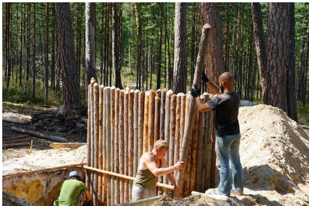
Рис.2.32. В рамках реализации проекта «Архитектура древней Югры», поддержанного Фондом президентских грантов производилось воссоздание фрагмента укрепленного поселения начала VI тыс. до н.э. Каюково 2. Монтаж стен жилища.
