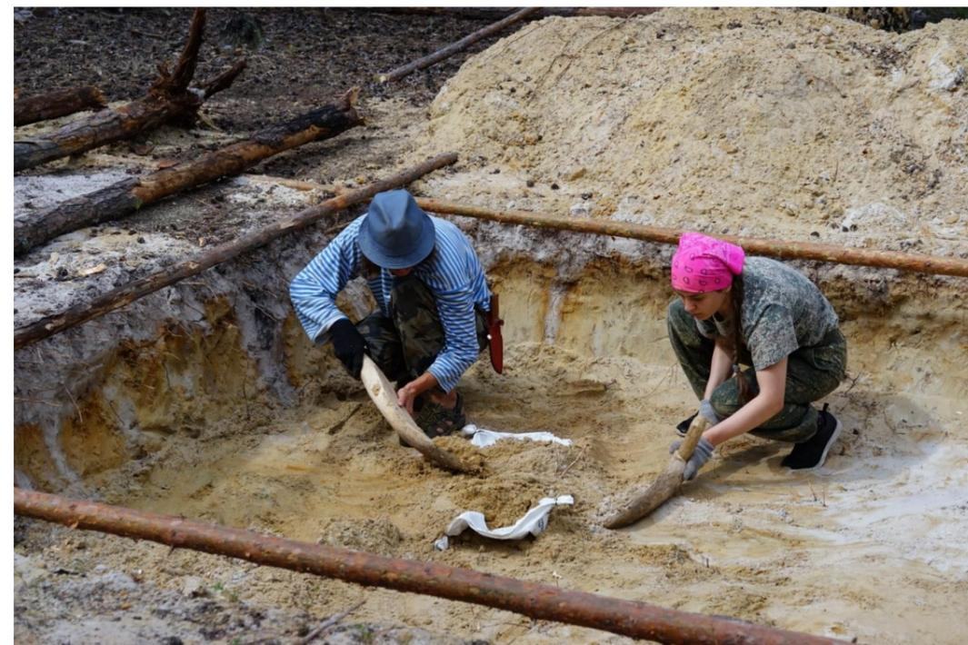
Рис.2.19. В рамках реализации проекта «Архитектура древней Югры», поддержанного Фондом президентских грантов, производилось воссоздание фрагмента укрепленного поселения начала VI тыс. до н.э. Каюково 2. Извлечение грунта из котлована постройки.
