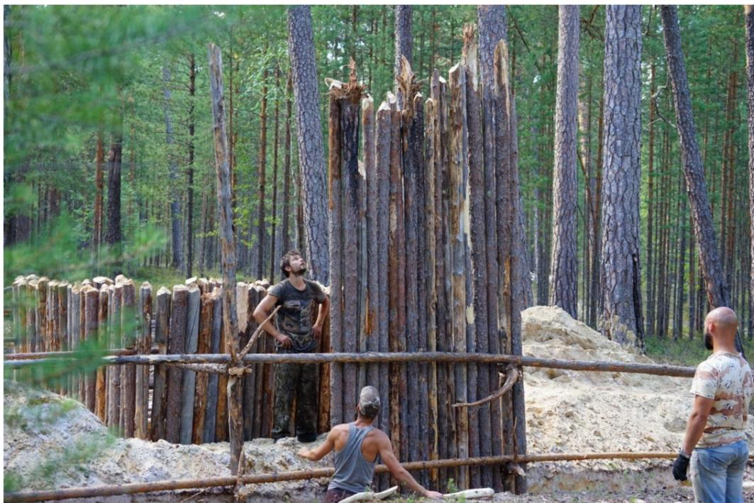
Рис.2.53. В рамках реализации проекта «Архитектура древней Югры», поддержанного Фондом президентских грантов, производилось воссоздание фрагмента укрепленного поселения начала VI тыс. до н.э. Каюково 2. Монтаж фрагмента оборонительной стены.
