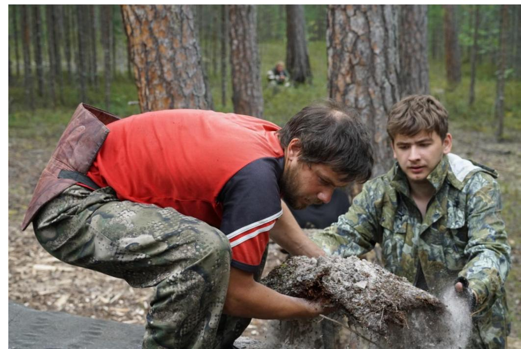
Рис.2.40. В рамках реализации проекта «Архитектура древней Югры», поддержанного Фондом президентских грантов, производилось воссоздание фрагмента укрепленного поселения начала VI тыс. до н.э. Каюково 2. Монтаж кровли, укладка дернового гнета.
