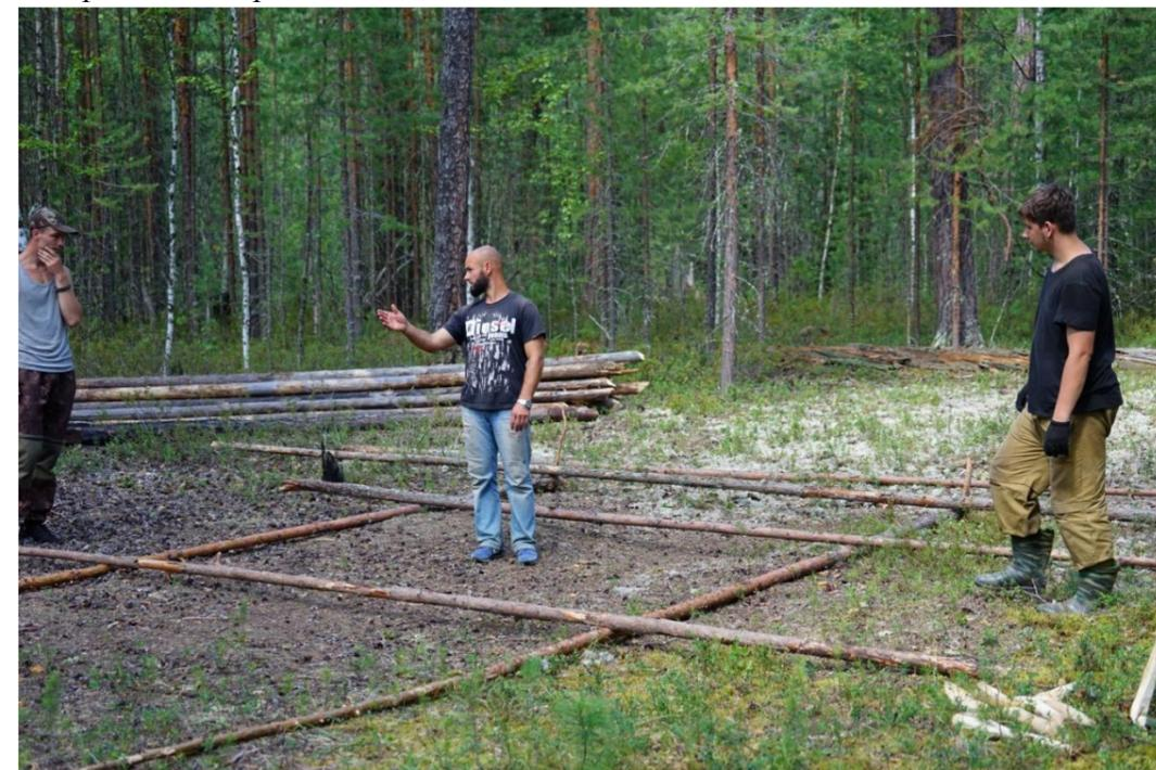
Рис.2.13. В рамках реализации проекта «Архитектура древней Югры», поддержанного Фондом президентских грантов, производилось воссоздание фрагмента укрепленного поселения начала VI тыс. до н.э. Каюково 2. Разметка котлована постройки.
