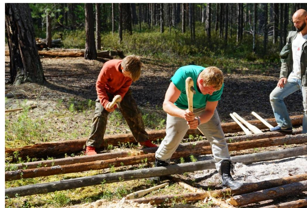
Рис.2.17. В рамках реализации проекта «Архитектура древней Югры», поддержанного Фондом президентских грантов, производилось воссоздание фрагмента укрепленного поселения начала VI тыс. до н.э. Каюково 2. Рубка деталей постройки аутентичными инструментами.
