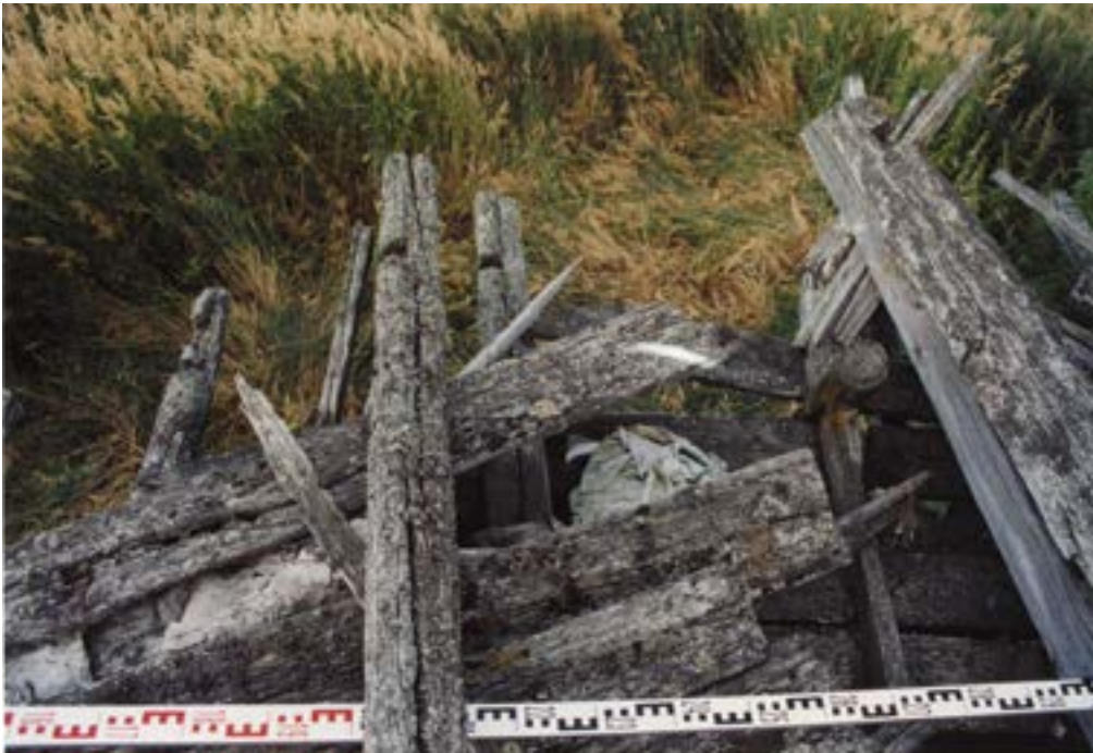
Рис. 135. Пос. Горноknязевск Приуральского района ЯНАО. Хозяйственный амбар Е.Н. Тайшиной. Конструкция кровли по слегам. Фрагмент охлупня. Вынос слег северо-восточного фронтона с пазами для горизонтальных конструкций. Паз в гнете – «ласточкин хвост». Вид сверху. Fig. 135. Gornoknyazevsk settlement, Priural district of the Yamal-Nenets Autonomous Okrug. Household barn of E. N. Tayshina. Roof structure. Extension of the north-eastern pediment with grooves for horizontal structures. View from above
