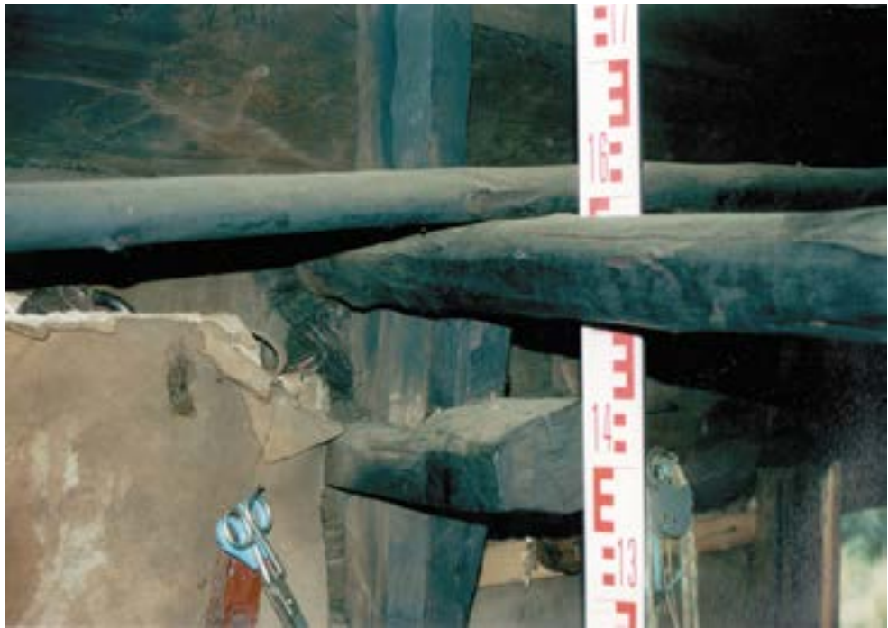
Рис. 72. Пос. Горноknязевск Приуральского района ЯНАО. Летний жилой дом Е.Н. Тайшиной. Интерьер. Фрагмент восточной стены. Система вешал. Крепление продольного вешала к левой стойке каркаса. Fig. 72. Gornoknyazevsk settlement, Priural district of the Yamal-Nenets Autonomous Okrug. Summer residential building of E. N. Tayshina. Interior. The eastern wall. Mounting unit for the frame post to the wall structure (middle tier). The hangers' system.
