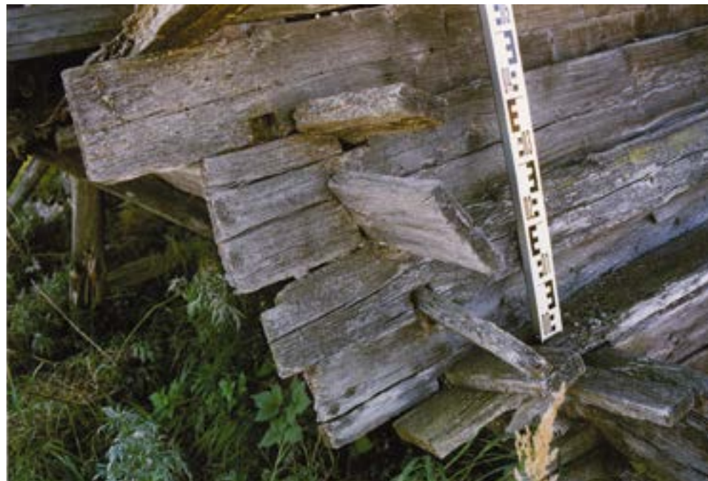
Рис. 124. Пос. Горноknязевск Приуральского района ЯНАО. Хозяйственный амбар Е.Н. Тайшиной. Фрагмент северо-западного фасада. Врубка стеновых плах.
