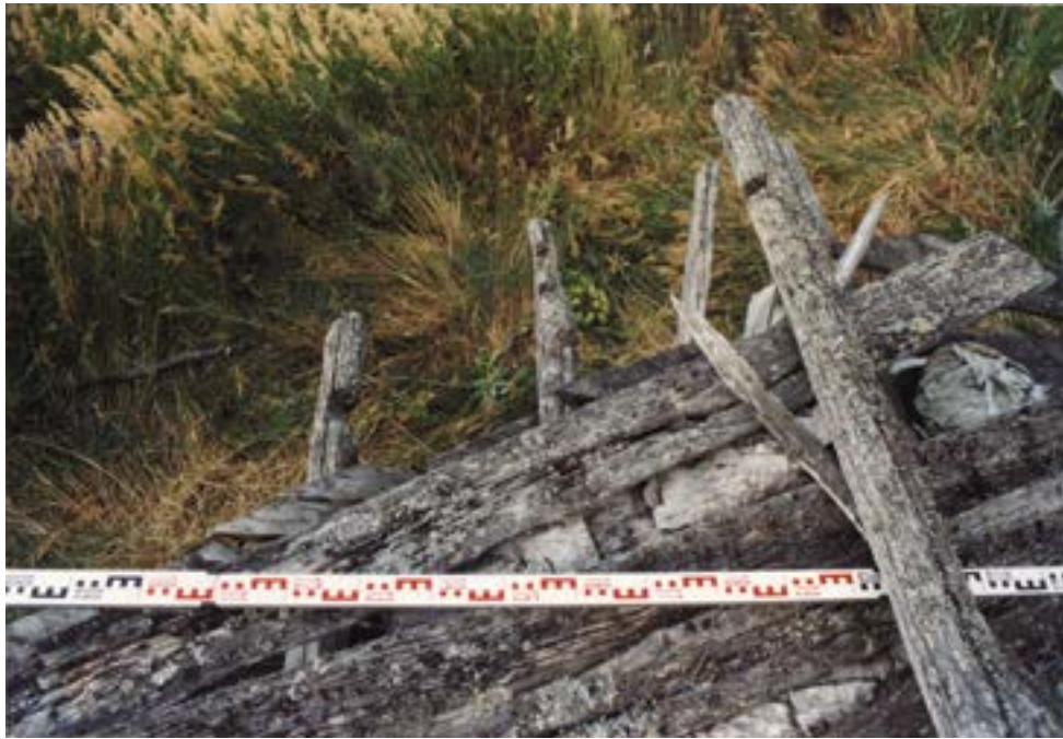
Рис. 136. Пос. Горноknязевск Приуральского района ЯНАО. Хозяйственный амбар Е.Н. Тайшиной. Конструкция кровли по слегам. Вынос слег северо-восточного фронтона с пазами для горизонтальных конструкций. Паз в гнете – «ласточкин хвост». Вид сверху. Fig. 136. Gornoknyazevsk settlement, Priural district of the Yamal-Nenets Autonomous Okrug. Household barn of E. N. Tayshina. Roof structure. Extension of the north-eastern pediment with grooves for horizontal structures. View from above
