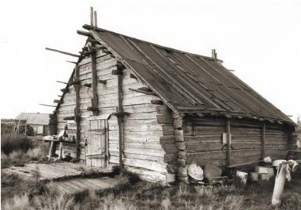
Рис. 42. Пос. Горноknязевск Приуральского района ЯНАО. Летний жилой дом Е.Н. Тайшиной. Вид с северо-востока. Fig. 42. Gornoknyazevsk settlement, Priural district of the Yamal-Nenets Autonomous Okrug. Summer residential building of E. N. Tayshina. View from the north-east
