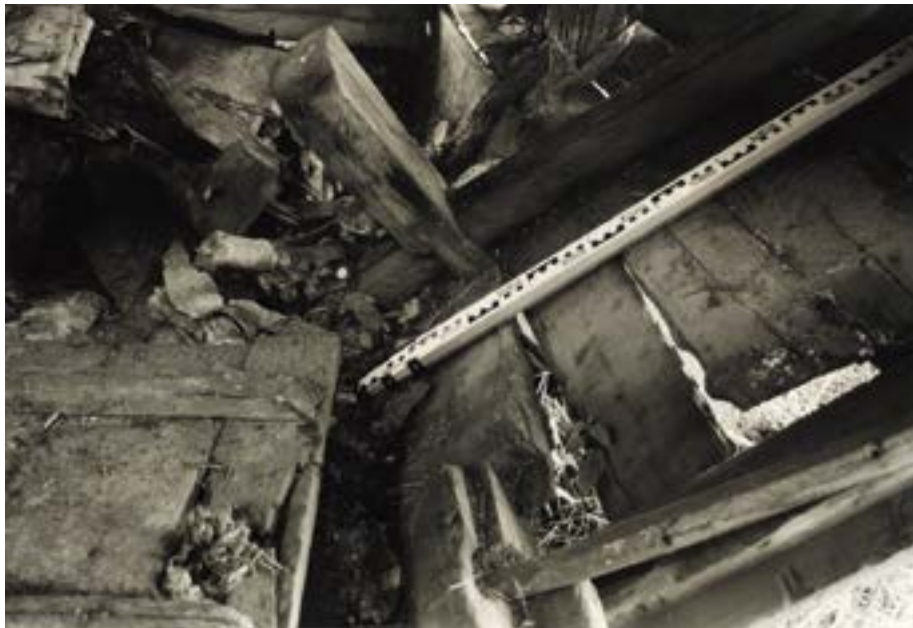
Рис. 111. Пос. Горноknязевск Приуральского района ЯНАО. Хозяйственный амбар Е.Н. Тайшиной. Фрагмент северо-восточной стены. Фрагмент плахи стенового ограждения, выполняющей функцию порога. Врубка для устройства дверной коробки. Узел крепления левой боковой стойки каркаса к стеновому ограждению деревянными вкладышами (нижний ярус, вид из интерьера).
