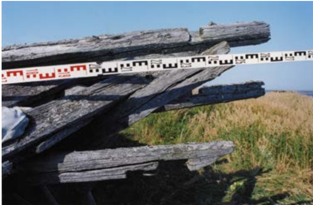
Рис. 139. Пос. Горноknязевск Приуральского района ЯНАО. Хозяйственный амбар Е.Н. Тайшиной. Конструкция кровли по слегам. Вынос слег северо-восточной стены фронтона с пазами для горизонтальных конструкций. Вид сбоку (юго-восток). Fig. 139. Gornoknyazevsk settlement, Priural district of the Yamal-Nenets Autonomous Okrug. Household barn of E. N. Tayshina. Roof structure. Extension of the north-eastern pediment with grooves for horizontal structures. View from the side (southeast)
