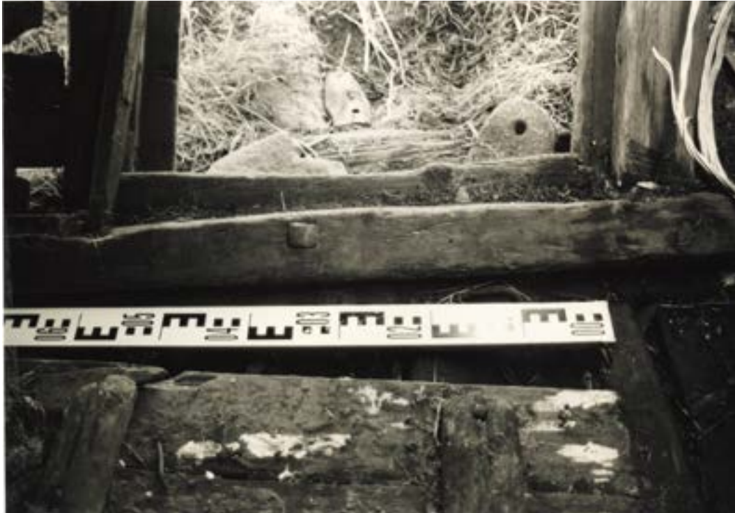
Рис. 102. Пос. Горноknязевск Приуральского района ЯНАО. Хозяйственный амбар Е.Н. Тайшиной. Фрагмент северо-восточной стены. Конструкция дверного блока. Порог (вид из интерьера). Fig. 102. Gornoknyazevsk settlement, Priural district of the Yamal-Nenets Autonomous Okrug. Household barn of E. N. Tayshina. Northeastern wall. Door block construction. Threshold (view from the interior).
