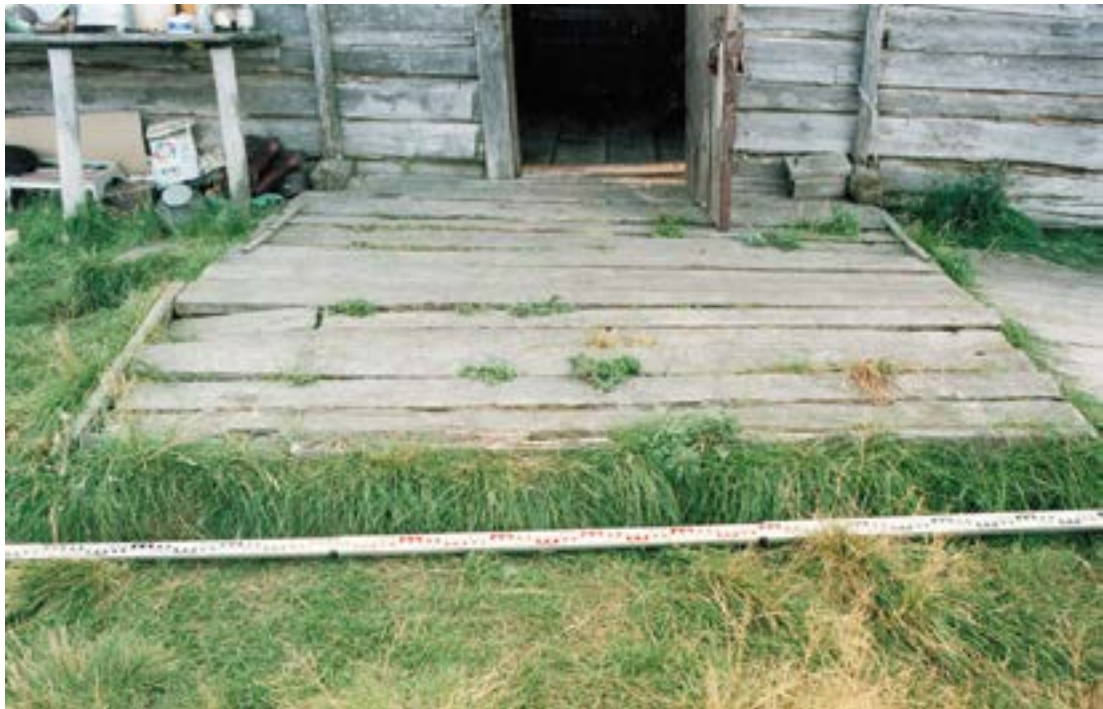
Рис. 45. Пос. Горноknязевск Приуральского района ЯНАО. Летний жилой дом Е.Н. Тайшиной. Восточный фасад. Предмостье. Fig. 45. Gornoknyazevsk settlement, Priural district of the Yamal-Nenets Autonomous Okrug. Summer residential building of E. N. Tayshina. The eastern facade. Bridgehead
