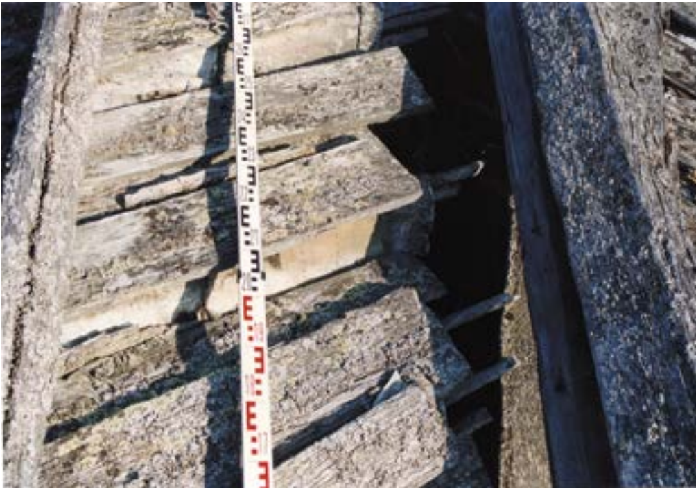
Рис. 134. Пос. Горноknязевск Приуральского района ЯНАО. Хозяйственный амбар Е.Н. Тайшиной. Конструкция кровли. Доски колотого теса. Сшитый из бересты сплошной гидроизоляционный ковер. Фрагмент обрешетки. Fig. 134. Gornoknyazevsk settlement, Priural district of the Yamal-Nenets Autonomous Okrug. Household barn of E. N. Tayshina. Roof structure. Birch bark carpet
