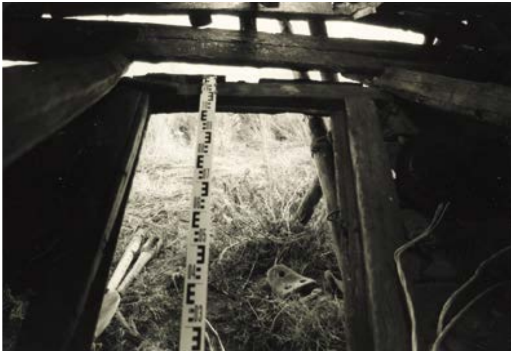
Рис. 105. Пос. Горнокнязевск Приуральского района ЯНАО. Хозяйственный амбар Е.Н. Тайшиной. Фрагмент северо-восточной стены. Конструкция дверного блока. Дверная коробка (вид из интерьера). Fig. 105. Gornoknyazevsk settlement, Priural district of the Yamal-Nenets Autonomous Okrug. Household barn of E. N. Tayshina. Northeastern wall. Door block construction (view from inside)
