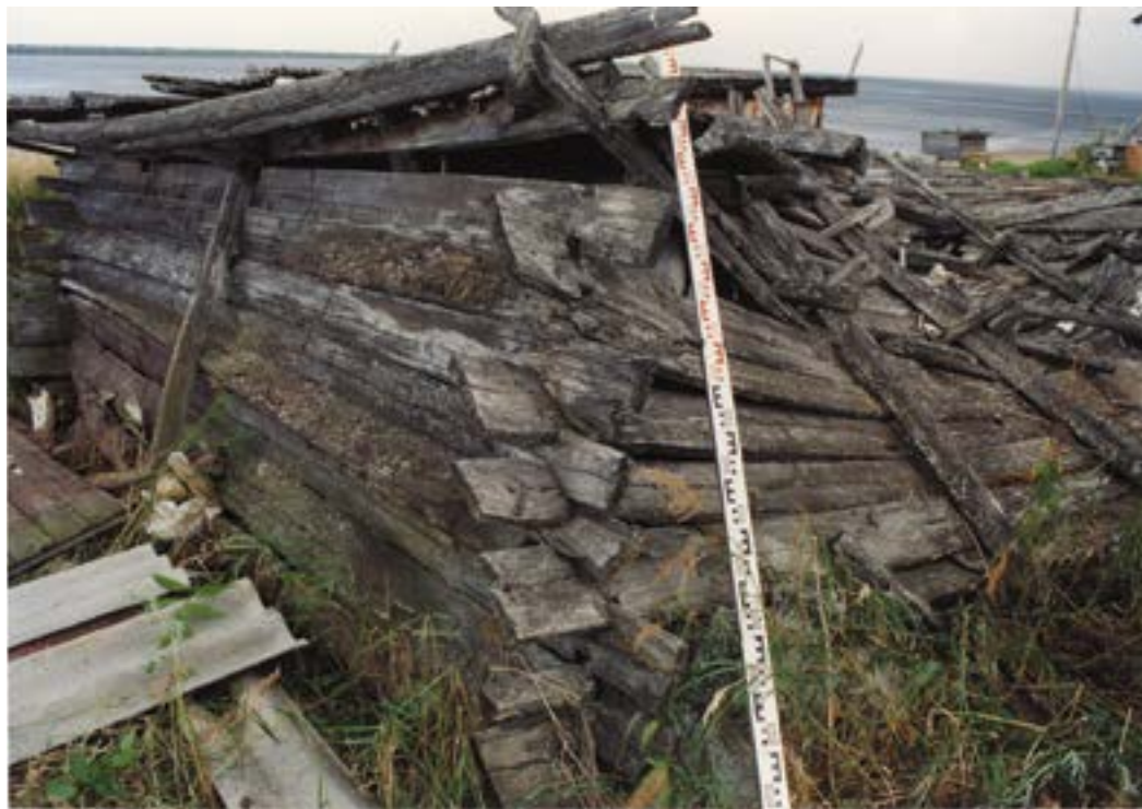
Рис. 122. Пос. Горноknязевск Приуральского района ЯНАО. Хозяйственный амбар Е.Н. Тайшиной. Фрагмент юго-западного фасада. Северо-западный фасад. Врубка стеновых плах. Fig. 122. Gornoknyazevsk settlement, Priural district of the Yamal-Nenets Autonomous Okrug. Household barn of E. N. Tayshina. Northwestern and southwestern walls. Wall planks.
