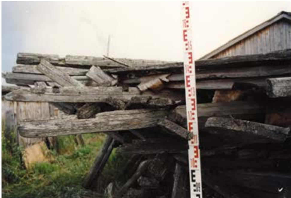
Рис. 137. Пос. Горноknязевск Приуральского района ЯНАО. Хозяйственный амбар Е.Н. Тайшиной. Конструкция кровли по слегам. Вынос слег северо-восточной стены с пазами для горизонтальных конструкций. Вид сбоку (северо-восток). Fig. 137. Gornoknyazevsk settlement, Priural district of the Yamal-Nenets Autonomous Okrug. Household barn of E. N. Tayshina. Roof structure. Extension of the north-eastern pediment with grooves for horizontal structures. View from the side (northeast)
