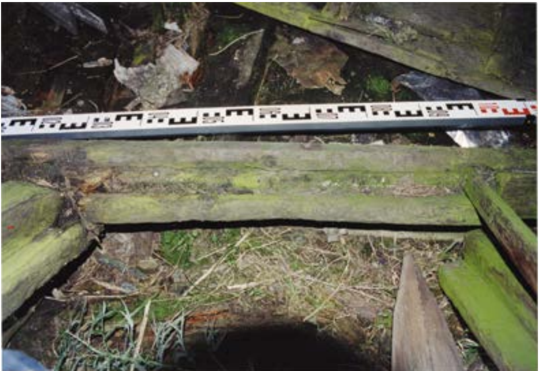
Рис. 101. Пос. Горноknязевск Приуральского района ЯНАО. Хозяйственный амбар Е.Н. Тайшиной. Фрагмент северо-восточного фасада. Конструкция дверного блока. Порог. Вид сверху. Fig. 101. Gornoknyazevsk settlement, Priural district of the Yamal-Nenets Autonomous Okrug. Household barn of E. N. Tayshina. Northeastern facade. Door construction. Threshold. View from above.
