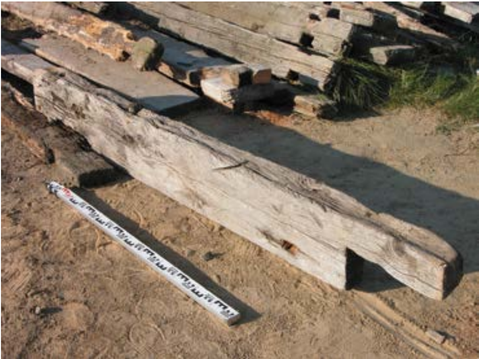
Рис. 144. Пос. Горнокнязевск Приуральского района ЯНАО. Хозяйственный амбар Е.Н. Тайшиной. Конструктивные особенности Fig. 144. Gornoknyazevsk settlement, Priural district of the Yamal-Nenets Autonomous Okrug. Household barn of E. N. Tayshina. Construction features
