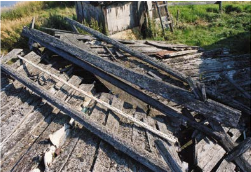
Рис. 133. Пос. Горноknязевск Приуральского района ЯНАО. Хозяйственный амбар Е.Н. Тайшиной. Конструкция кровли. Коньковая слега. Охлупень нанизан на центральные фасадные стойки каркаса и дополнительно укреплен клиньями. Гнеты. Вид с запада. Fig. 133. Gornoknyazevsk settlement, Priural district of the Yamal-Nenets Autonomous Okrug. Household barn of E. N. Tayshina. Roof structure. Central facade frame. View from the west
