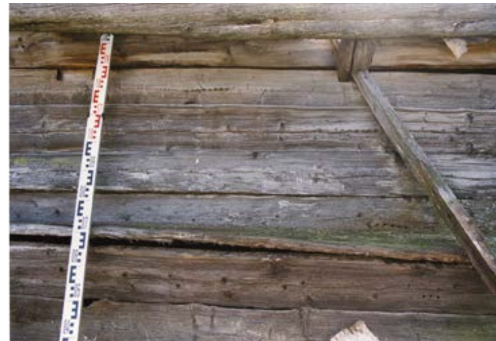
Рис. 126. Пос. Горноknязевск Приуральского района ЯНАО. Хозяйственный амбар Е.Н. Тайшиной. Фрагмент северо-западного фасада. Паз под вкладыш для правой стойки каркаса и узел крепления левой стойки каркаса деревянным вкладышем к стеновому ограждению (верхний ярус). Маркировка венцов (плах) высверленными отверстиями (количественное увеличение – снизу вверх). Фрагмент потока.
