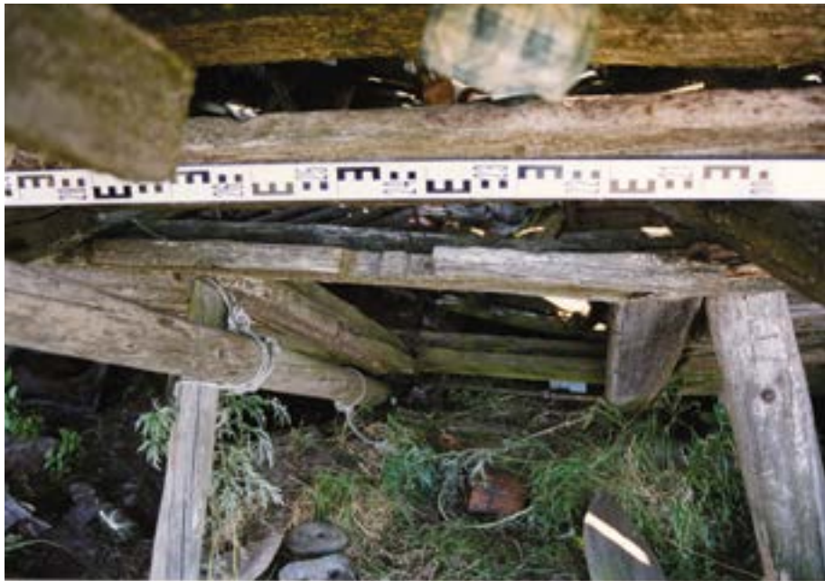
Рис. 110. Пос. Горноknязевск Приуральского района ЯНАО. Хозяйственный амбар Е.Н. Тайшиной. Фрагмент северо-восточного фасада. Паз в стеновом ограждении для стяжки и крепления центральных стоек каркаса деревянными вкладышами (средний ярус).
