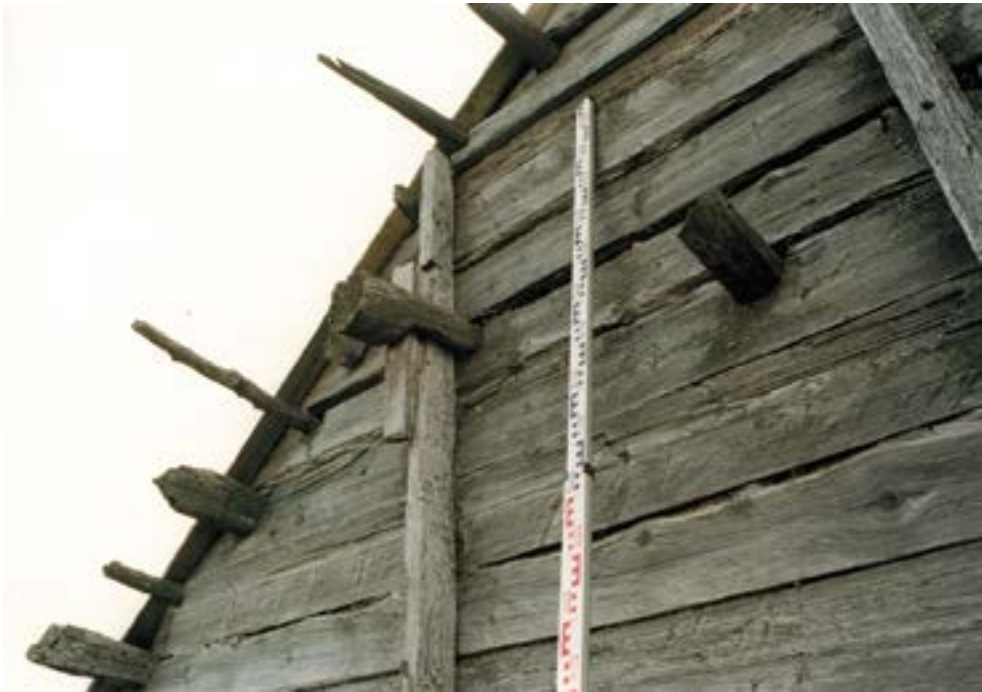
Рис. 50. Пос. Горноknязевск Приуральского района ЯНАО. Летний жилой дом Е.Н. Тайшиной. Фрагмент восточного фасада. Фрагмент фронтона. Узел крепления левой стойки каркаса к стеновой конструкции (верхний ярус). Вид с северо-востока. Fig. 50. Gornoknyazevsk settlement, Priural district of the Yamal-Nenets Autonomous Okrug. Summer residential building of E. N. Tayshina. The eastern facade. Pediment fragment. Mounting unit for the left frame post to the wall structure (upper tier). View from the northeast.
