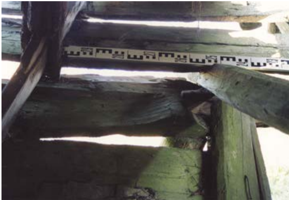
Рис. 108. Пос. Горноknязевск Приуральского района ЯНАО. Хозяйственный амбар Е.Н. Тайшиной. Фрагмент северо-восточной стены. Фрагмент плахи стенового ограждения, выполняющей функцию вершника. Стеска «в лас» (вид из интерьера).
