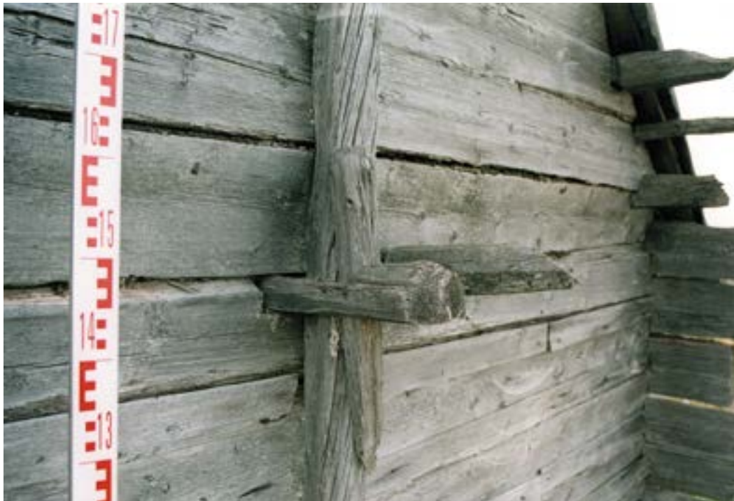
Рис. 48. Пос. Горноknязевск Приуральского района ЯНАО. Летний жилой дом Е.Н. Тайшиной. Фрагмент восточного фасада. Узел крепления правой стойки каркаса к стеновой конструкции (средний ярус). Вид с юго-востока. Fig. 48. Gornoknyazevsk settlement, Priural district of the Yamal-Nenets Autonomous Okrug. Summer residential building of E. N. Tayshina. Fragment of the eastern facade. The attachment point for the right post of the frame to the wall structure (middle tier). View from the southeast.
