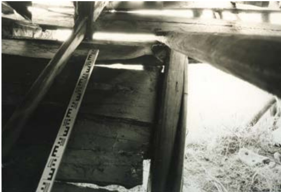
Рис. 109. Пос. Горноknязевск Приуральского района ЯНАО. Хозяйственный амбар Е.Н. Тайшиной. Фрагмент северо-восточной стены. Фрагмент дверной коробки. Фрагмент плахи стенового ограждения, выполняющей конструктивную функцию вершника. Стеска «в лас». Фрагмент левой боковой стойки каркаса и узел крепления к стеновому ограждению деревянными вкладышами (вид из интерьера).
