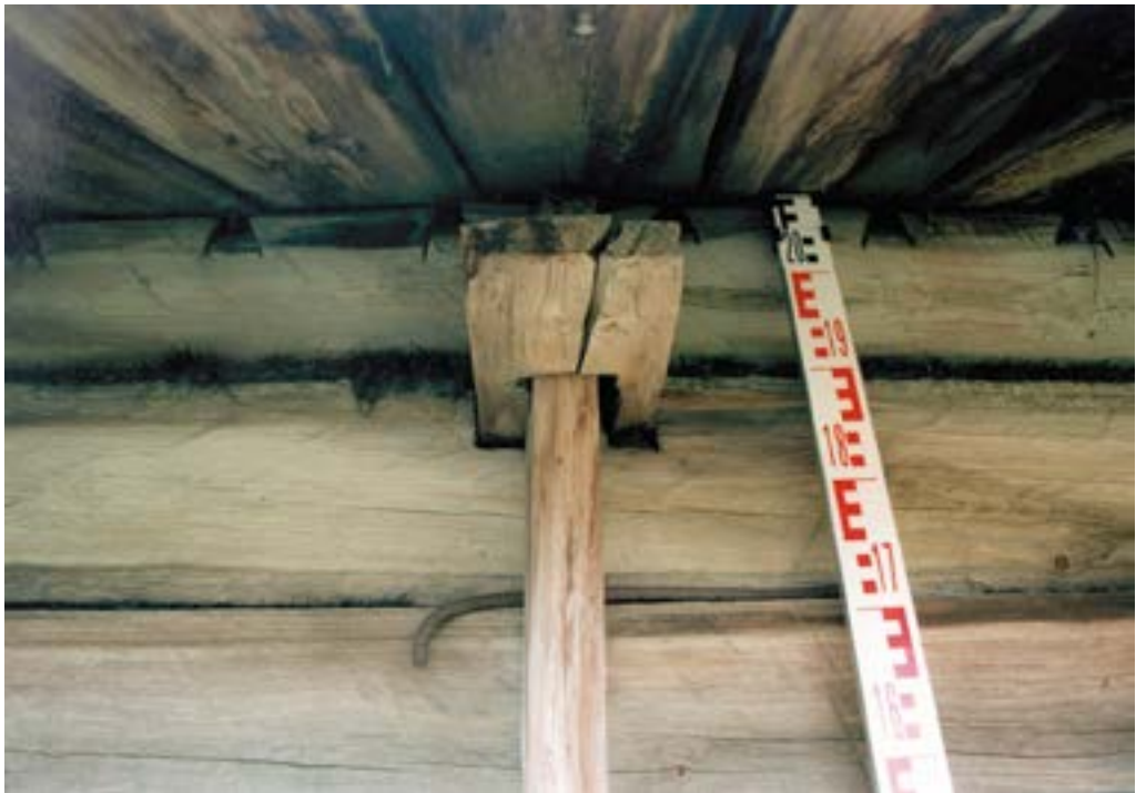
Рис. 59. Пос. Горнокнязевск Приуральского района ЯНАО. Летний жилой дом Е.Н. Тайшиной. Фрагмент южного фасада. Узел крепления правой стойки каркаса к стеновой конструкции (верхний ярус). Вид с юга Fig. 59. Gornoknyazevsk settlement, Priural district of the Yamal-Nenets Autonomous Okrug. Summer residential building of E. N. Tayshina. The southern facade. The attachment point for the right post of the frame to the wall structure (upper tier). View from the south
