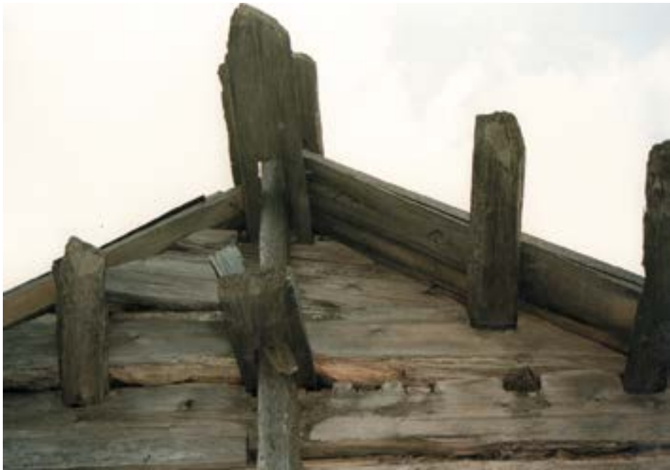
Рис. 52. Пос. Горноknязевск Приуральского района ЯНАО. Летний жилой дом Е.Н. Тайшиной. Фрагмент восточного фасада. Фрагмент фронтона. Узел крепления центральной стойки каркаса к стеновой конструкции (верхний ярус) и к коньковой слеге. Fig. 52. Gornoknyazevsk settlement, Priural district of the Yamal-Nenets Autonomous Okrug. Summer residential building of E. N. Tayshina. The eastern facade. Pediment fragment. Mounting unit for the central post of the frame to the wall structure (upper tier) and to the ridge sledge.
