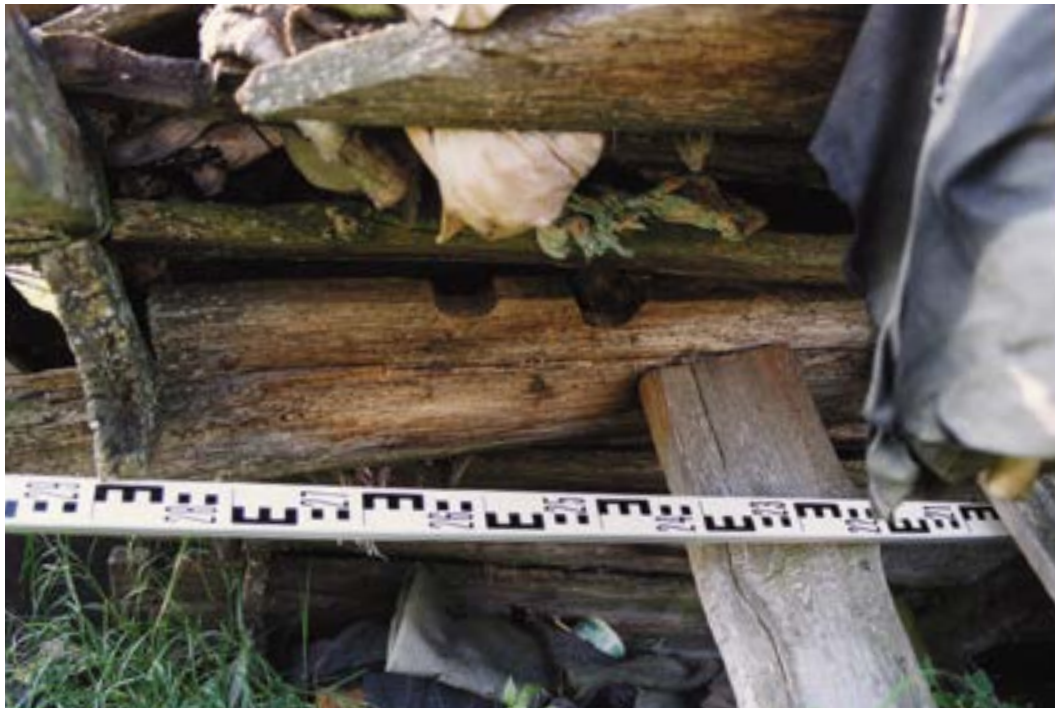
Рис. 114. Пос. Горнокнязевск Приуральского района ЯНАО. Хозяйственный амбар Е.Н. Тайшиной. Фрагмент северо-восточного фасада. Пазы для вешал (левая часть фасада). Fig. 114. Gornoknyazevsk settlement, Priural district of the Yamal-Nenets Autonomous Okrug. Household barn of E. N. Tayshina. Northeastern wall. Grooves for hanging (left side of the facade).
