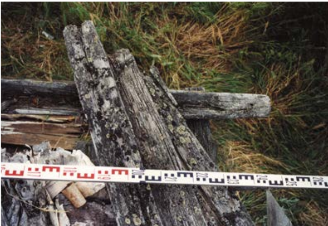
Рис. 129. Пос. Горнокнязевск Приуральского района ЯНАО. Хозяйственный амбар Е.Н. Тайшиной. Фрагмент северо-западного фасада. Фрагмент потока, декоративная обработка потока (вид сверху). Fig. 129. Gornoknyazevsk settlement, Priural district of the Yamal-Nenets Autonomous Okrug. Household barn of E. N. Tayshina. Northwestern wall construction (view from above)
