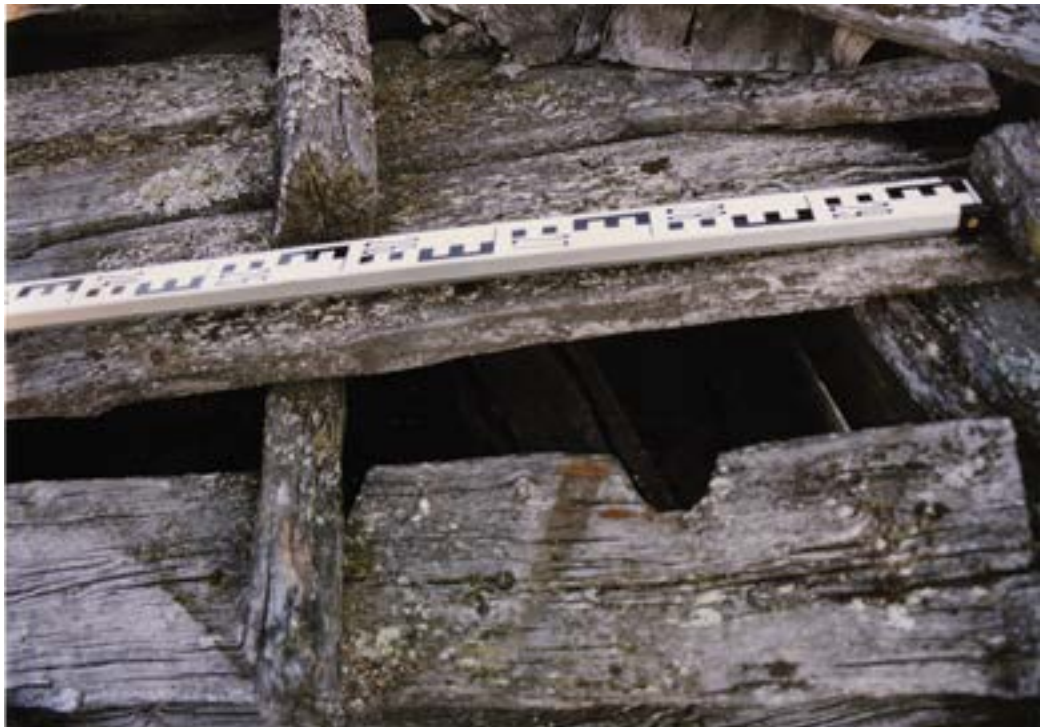
Рис. 121. Пос. Горноknязевск Приуральского района ЯНАО. Хозяйственный амбар Е.Н. Тайшиной. Фрагмент юго-западного фасада (правая сторона). Вешала. Fig. 121. Gornoknyazevsk settlement, Priural district of the Yamal-Nenets Autonomous Okrug. Household barn of E. N. Tayshina. Southwestern wall (right side). Hangers.
