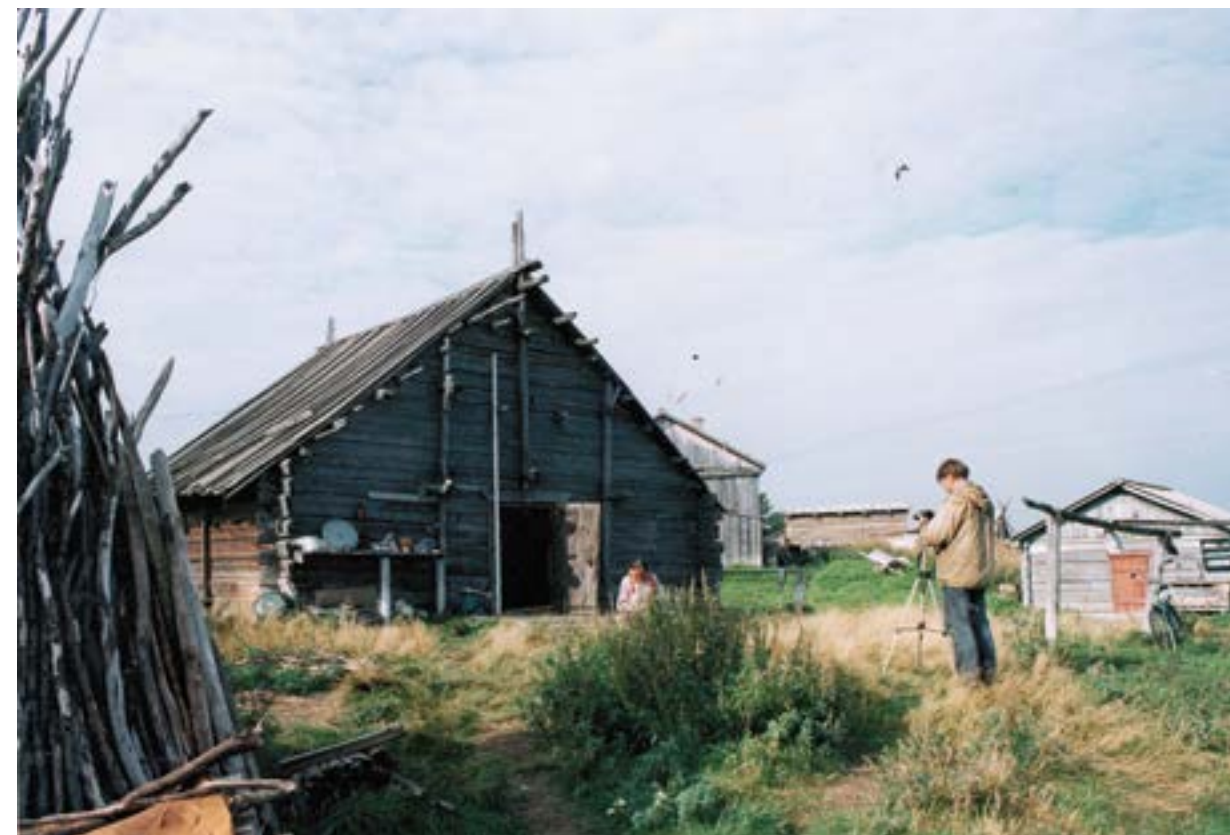
Рис. 39. Пос. Горноknязевск Приуральского района ЯНАО. Фотофиксация объекта.
