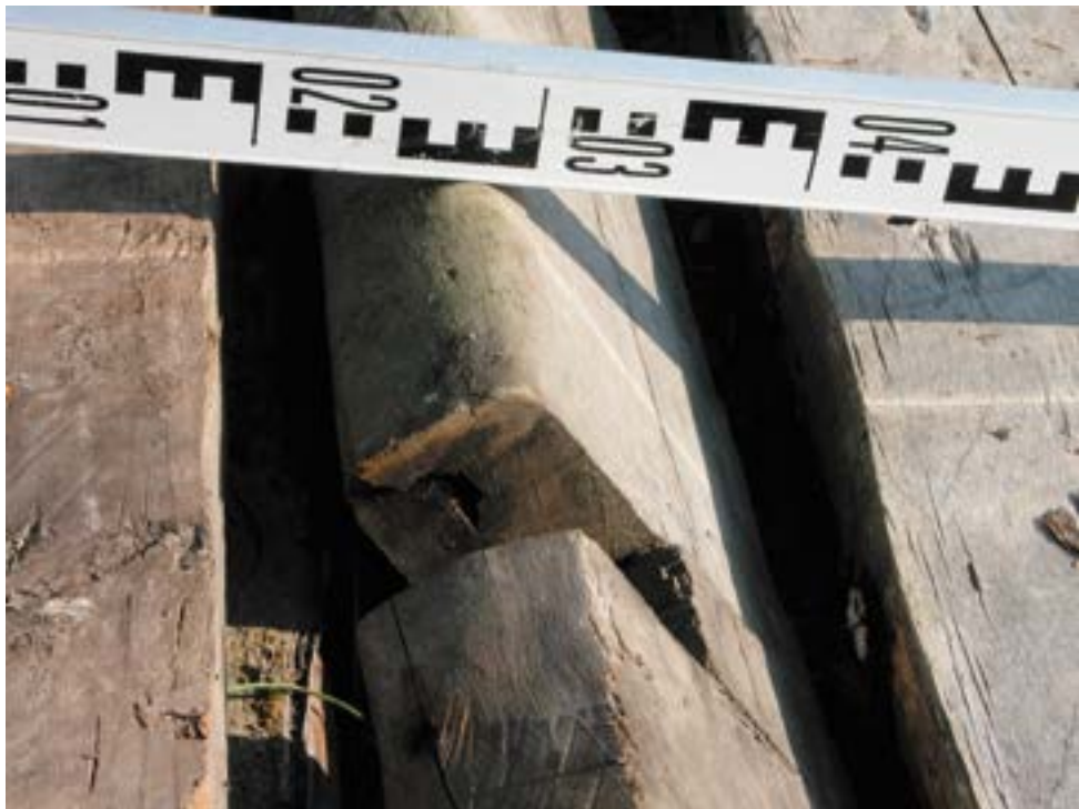
Рис. 147. Пос. Горноknязевск Приуральского района ЯНАО. Хозяйственный амбар Е.Н. Тайшиной. Конструктивные особенности Fig. 147. Gornoknyazevsk settlement, Priural district of the Yamal-Nenets Autonomous Okrug. Household barn of E. N. Tayshina. Construction features
