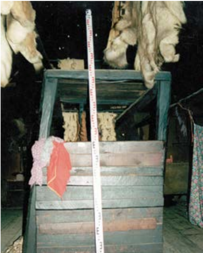
Рис. 79 Пос. Горноknязевск Приуральского района ЯНАО. Летний жилой дом Е. Н. Тайшиной. Интерьер. Конструкция очага. Деревянная забирка напротив входа в дом. Fig. 79. Gornoknyazevsk settlement, Priural district of the Yamal-Nenets Autonomous Okrug. Summer residential building of E. N. Tayshina. Interior. Hearth construction. A wooden fence opposite the entrance to the house.
