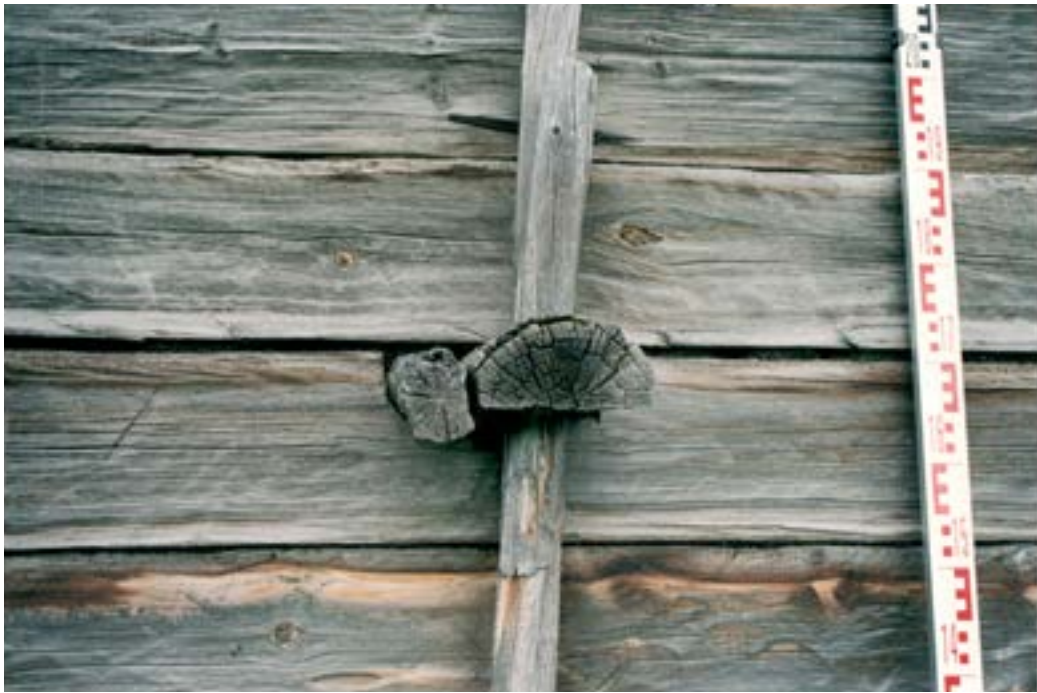
Рис. 64. Пос. Горнокнязевск Приуральского района ЯНАО. Летний жилой дом Е.Н. Тайшиной. Фрагмент западного фасада. Узел крепления левой стойки каркаса к стеновой конструкции (средний ярус), вешало. Вид с запада. Fig. 64. Gornoknyazevsk settlement, Priural district of the Yamal-Nenets Autonomous Okrug. Summer residential building of E. N. Tayshina. The western facade. Mounting unit for the left frame post to the wall structure (middle tier), hanger. View from the west.
