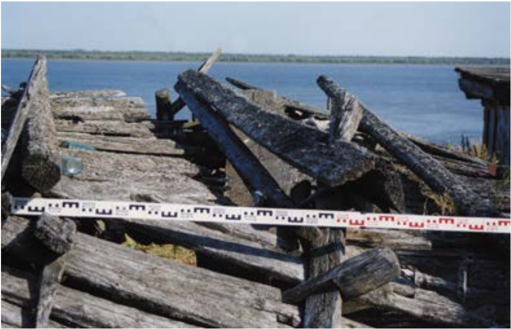
Рис. 132. Пос. Горноknязевск Приуральского района ЯНАО. Хозяйственный амбар Е.Н. Тайшиной. Конструкция кровли. Коньковая слега. Охлупень нанизан на центральные фасадные стойки каркаса и дополнительно укреплен клиньями. Форма желоба охлупня. Гнеты. Вид с юго-запада Fig. 132. Gornoknyazevsk settlement, Priural district of the Yamal-Nenets Autonomous Okrug. Household barn of E. N. Tayshina. Roof structure. Central façade pillars and additional reinforced wedges. View from the southwest
