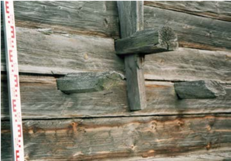
Рис. 65. Пос. Горноknязевск Приуральского района ЯНАО. Летний жилой дом Е.Н. Тайшиной. Фрагмент западного фасада. Узел крепления центральной стойки каркаса к стеновой конструкции (нижний ярус). Вынос балок каркасной конструкции очага. Вид с северо-запада. Fig. 65. Gornoknyazevsk settlement, Priural district of the Yamal-Nenets Autonomous Okrug. Summer residential building of E. N. Tayshina. The western facade. The attachment point for the central post of the frame to the wall structure (lower tier). Beams of the hearth frame structure. View from the northwest.
