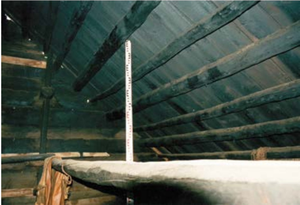
Рис. 76. Пос. Горноknязевск Приуральского района ЯНАО. Летний жилой дом Е.Н. Тайшиной. Интерьер. Вид на восточную стену. Устройство кровли по слегам. Fig. 76. Gornoknyazevsk settlement, Priural district of the Yamal-Nenets Autonomous Okrug. Summer residential building of E. N. Tayshina. Interior. View on the eastern wall. Roof system with poles.
