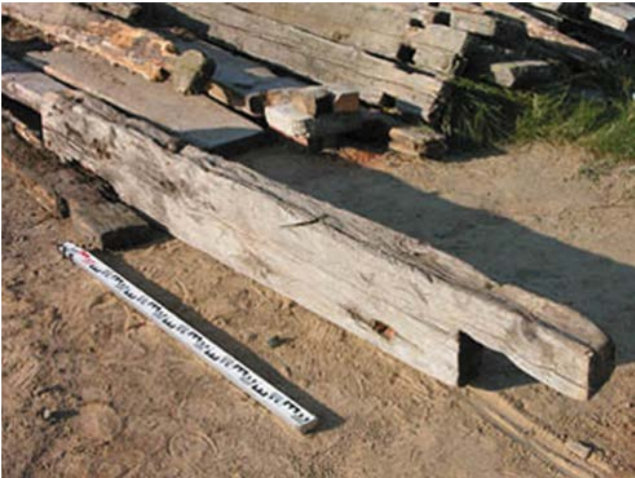
Рис. 151. Пос. Горнокнязевск Приуральского района ЯНАО. Хозяйственный амбар Е.Н. Тайшиной. Конструктивные особенности Fig. 151. Gornoknyazevsk settlement, Priural district of the Yamal-Nenets Autonomous Okrug. Household barn of E. N. Tayshina. Construction features
