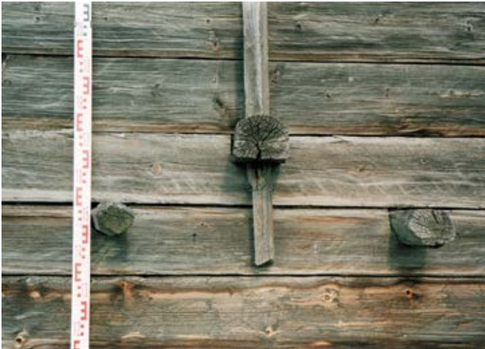
Рис. 66. Пос. Горноknязевск Приуральского района ЯНАО. Летний жилой дом Е.Н. Тайшиной. Фрагмент западного фасада. Узел крепления центральной стойки каркаса к стеновой конструкции (нижний ярус). Вынос балок каркасной конструкции очага. Вид с запада. Fig. 66. Gornoknyazevsk settlement, Priural district of the Yamal-Nenets Autonomous Okrug. Summer residential building of E. N. Tayshina. The western facade. The attachment point for the central post of the frame to the wall structure (lower tier). Beams of the hearth frame structure. View from the west.
