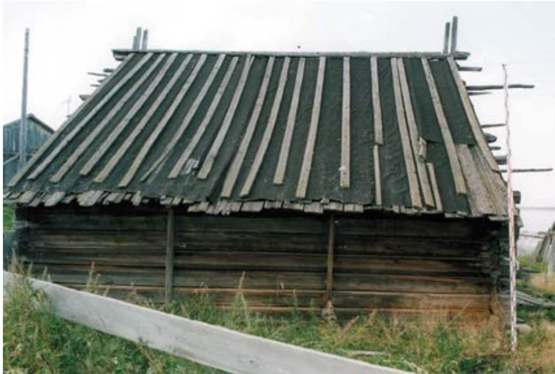
Рис. 53. Пос. Горноknязевск Приуральского района ЯНАО. Летний жилой дом Е.Н. Тайшиной. Южный фасад. Fig. 53. Gornoknyazevsk settlement, Priural district of the Yamal-Nenets Autonomous Okrug. Summer residential building of E. N. Tayshina. The southern facade.
