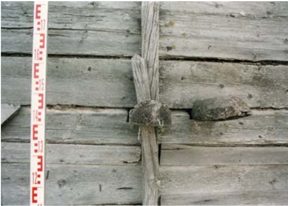
Рис. 49. Пос. Горноknязевск Приуральского района ЯНАО. Летний жилой дом Е.Н. Тайшиной. Фрагмент восточного фасада. Узел крепления правой стойки каркаса к стеновой конструкции (средний ярус). Вид с востока. Fig. 49. Gornoknyazevsk settlement, Priural district of the Yamal-Nenets Autonomous Okrug. Summer residential building of E. N. Tayshina. The eastern facade. attachment point for the right post of the frame to the wall structure (middle tier). View from the east.
