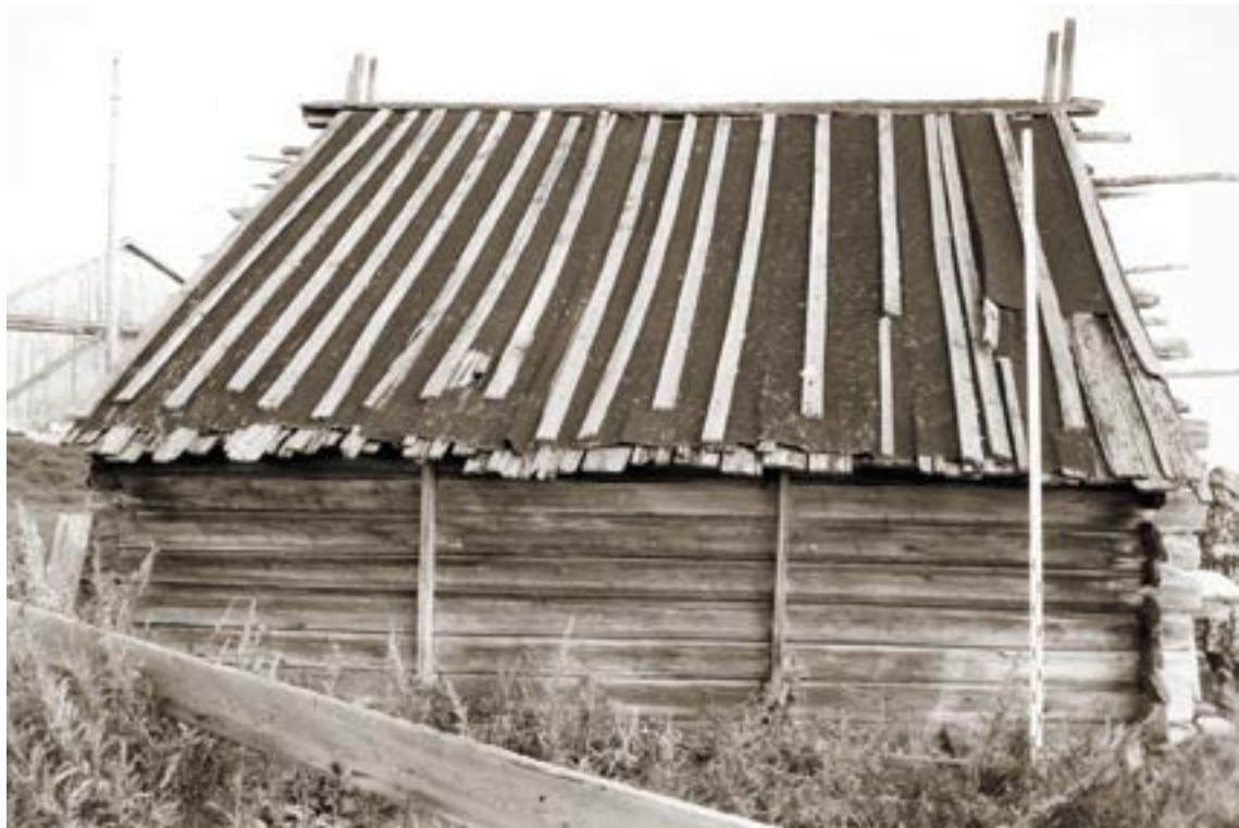
Рис. 54. Пос. Горноknязевск Приуральского района ЯНАО. Летний жилой дом Е.Н. Тайшиной. Южный фасад. Fig. 54. Gornoknyazevsk settlement, Priural district of the Yamal-Nenets Autonomous Okrug. Summer residential building of E. N. Tayshina. The southern facade.
