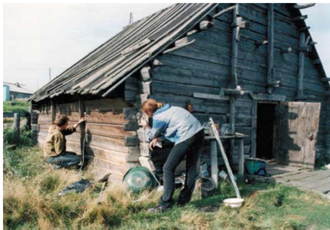
Рис. 38. Пос. Горноknязевск Приуральского района ЯНАО. Пробивка «нулевой» отметки на фасадах при помощи водного уровня.
