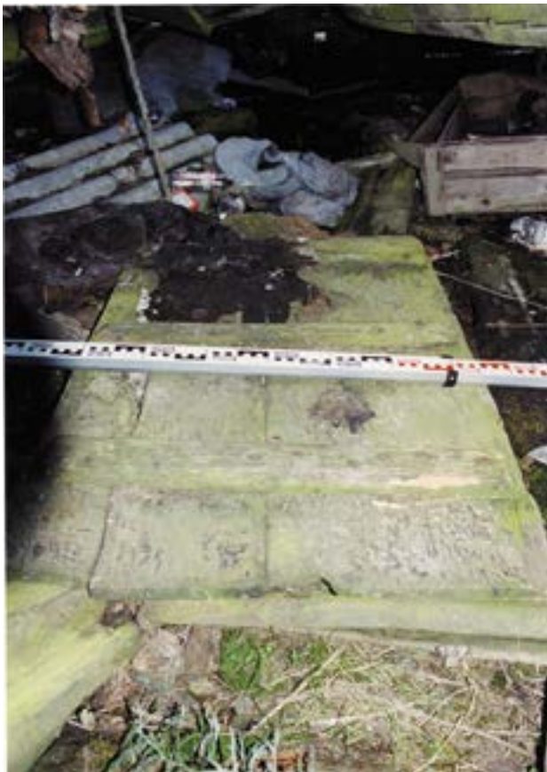
Рис. 106. Пос. Горнокнязевск Приуральского района ЯНАО. Хозяйственный амбар Е.Н. Тайшиной. Фрагмент северо-восточной стены. Конструкция дверного блока с неполной дверной коробкой, верхник отсутствует. Четверть выбрана в плаше стенового ограждения (вид из интерьера). Fig. 106. Gornoknyazevsk settlement, Priural district of the Yamal-Nenets Autonomous Okrug. Household barn of E. N. Tayshina. Northeastern wall. Door block construction with an incomplete door frame, the top is missing (view from the interior).
