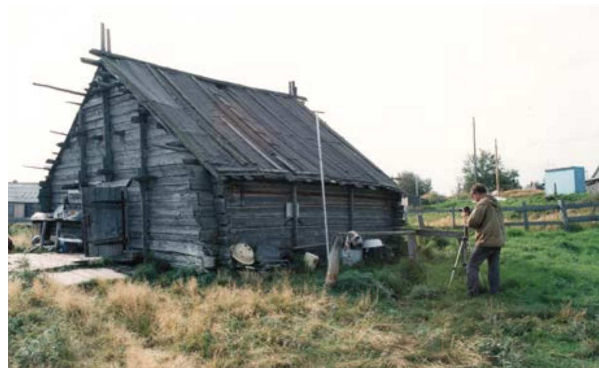
Рис. 40. Пос. Горноknязевск Приуральского района ЯНАО. Фотофиксация объекта.
