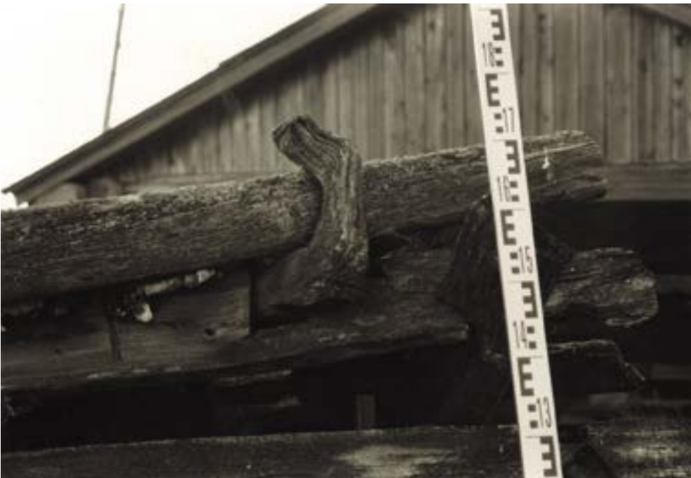
Рис. 131. Пос. Горнокнязевск Приуральского района ЯНАО. Хозяйственный амбар Е.Н. Тайшиной. Фрагмент северо-западного фасада. Фрагмент потока. Врубка курицы, поддерживающей поток. Подрезка «ноги» курицы, создающая дополнительный упор, препятствующий «сползанию» конструкции кровли. Fig. 131. Gornoknyazevsk settlement, Priural district of the Yamal-Nenets Autonomous Okrug. Household barn of E. N. Tayshina. Northwestern wall construction. Creating an additional support that prevents the roof structure from “sliding”.
