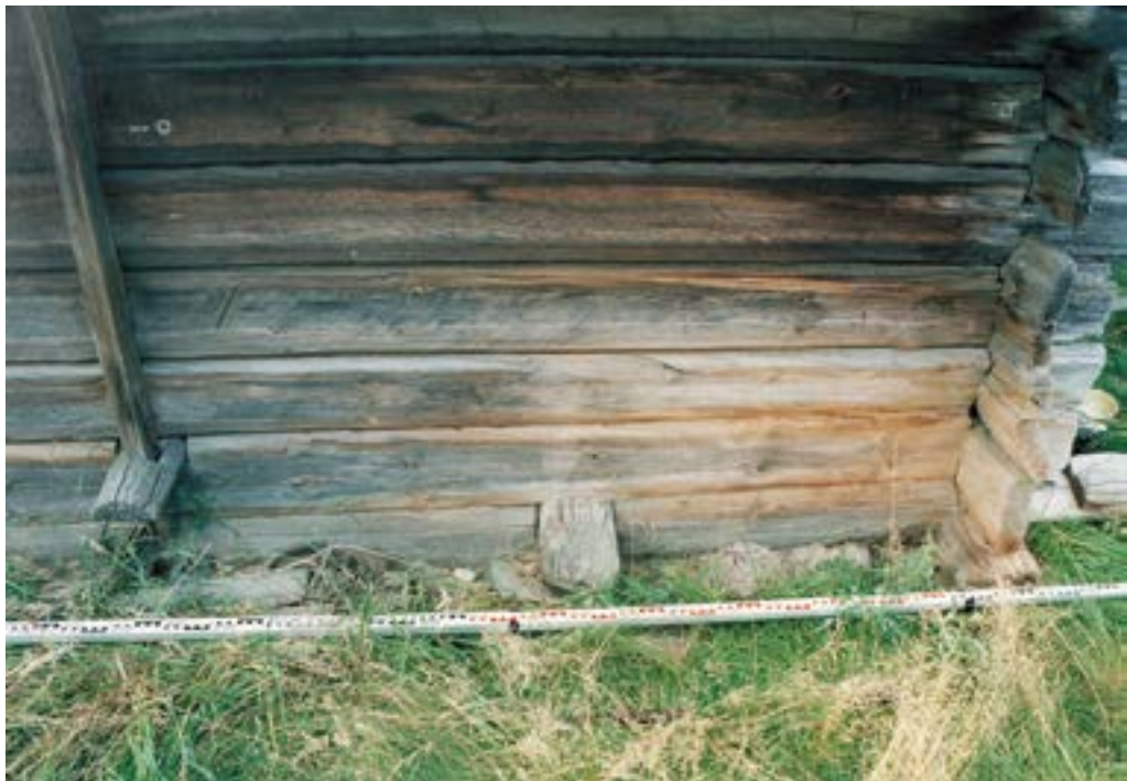
Рис. 57. Пос. Горнокнязевск Приуральского района ЯНАО. Летний жилой дом Е.Н. Тайшиной. Фрагмент южного фасада. Врубка балки перекрытия. Узел крепления правой стойки каркаса к стеновой конструкции. Вид с юга. Fig. 57. Gornoknyazevsk settlement, Priural district of the Yamal-Nenets Autonomous Okrug. Summer residential building of E. N. Tayshina. The southern facade. Notching the floor beam. The attachment point for the right frame post to the wall structure. View from the south.
