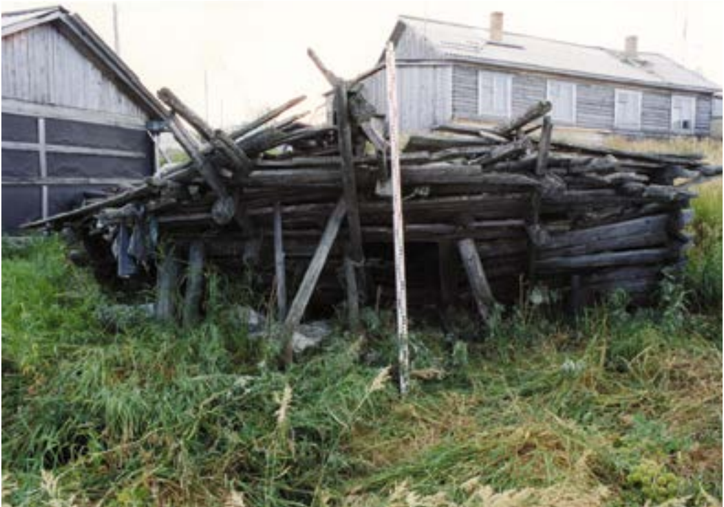
Рис. 100. Пос. Горноknязевск Приуральского района ЯНАО. Хозяйственный амбар Е.Н. Тайшиной. Северо-восточный фасад. Fig. 100. Gornoknyazevsk settlement, Priural district of the Yamal-Nenets Autonomous Okrug. Household barn of E. N. Tayshina. Northeastern facade
