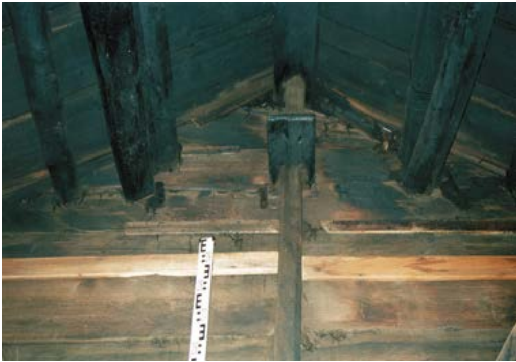
Рис. 75. Пос. Горноknязевск Приуральского района ЯНАО. Летний жилой дом Е.Н. Тайшиной. Интерьер. Фрагмент восточной стены, фронтон. Узел крепления центральной стойки каркаса к стеновой конструкции (верхний ярус). Fig. 75. Gornoknyazevsk settlement, Priural district of the Yamal-Nenets Autonomous Okrug. Summer residential building of E. N. Tayshina. Interior. The eastern wall, pediment. Mounting unit for the frame post to the wall structure (middle tier). The hangers' system.
