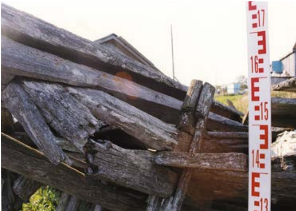
Рис. 116. Пос. Горноknязевск Приуральского района ЯНАО. Хозяйственный амбар Е.Н. Тайшиной. Фрагмент северо-восточного фасада. Фрагмент фронтона. Узел крепления центральных стоек каркаса к стеновому ограждению при помощи деревянного вкладыша. Клинья дополнительно стягивают конструкцию. Fig. 116. Gornoknyazevsk settlement, Priural district of the Yamal-Nenets Autonomous Okrug. Household barn of E. N. Tayshina. Northeastern wall. Pediment fragment. The attachment point for the central pillars of the frame to the wall fencing with a wooden insert. Wedges additionally tighten the structure.
