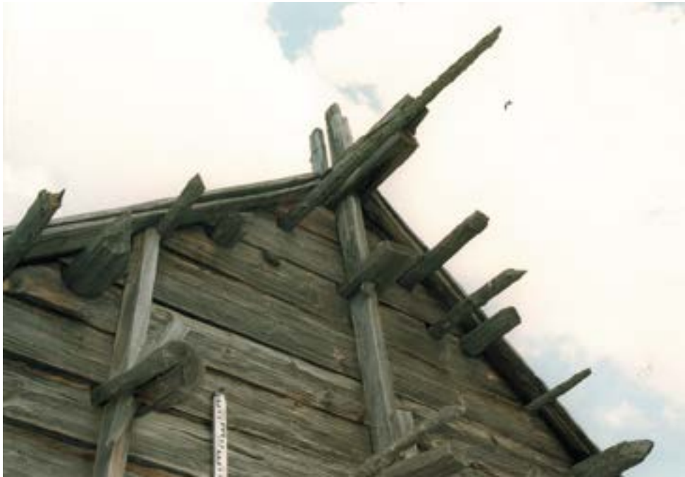
Рис. 67. Пос. Горноknязевск Приуральского района ЯНАО. Летний жилой дом Е.Н. Тайшиной. Фрагмент западного фасада. Фрагмент фронтона. Узлы крепления левой и центральной стоек каркаса к стеновой конструкции (верхний ярус). Устройство конька. Вид с северо-запада. Fig. 67. Gornoknyazevsk settlement, Priural district of the Yamal-Nenets Autonomous Okrug. Summer residential building of E. N. Tayshina. The western facade. Pediment fragment. Mounting points for the left and central pillars of the frame to the wall structure (top tier). The roof ridge. View from the northwest.
