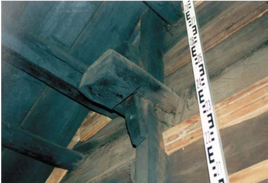
Рис. 73 Пос. Горноknязевск Приуральского района ЯНАО. Летний жилой дом Е.Н. Тайшиной. Интерьер. Фрагмент восточной стены. Узел крепления левой стойки каркаса к стеновой конструкции (верхний ярус). Fig. 73. Gornoknyazevsk settlement, Priural district of the Yamal-Nenets Autonomous Okrug. Summer residential building of E. N. Tayshina. Interior. The eastern wall. Mounting unit for the left frame post to the wall structure (upper tier).
