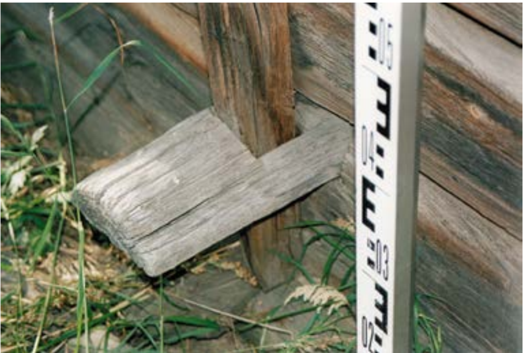
Рис. 60. Пос. Горнокнязевск Приуральского района ЯНАО. Летний жилой дом Е.Н. Тайшиной. Фрагмент южного фасада. Узел крепления правой стойки каркаса к стеновой конструкции (нижний ярус). Вид с юго-востока. Fig. 60. Gornoknyazevsk settlement, Priural district of the Yamal-Nenets Autonomous Okrug. Summer residential building of E. N. Tayshina. The southern facade. The attachment point for the right post of the frame to the wall structure (lower tier). View from the southeast.
