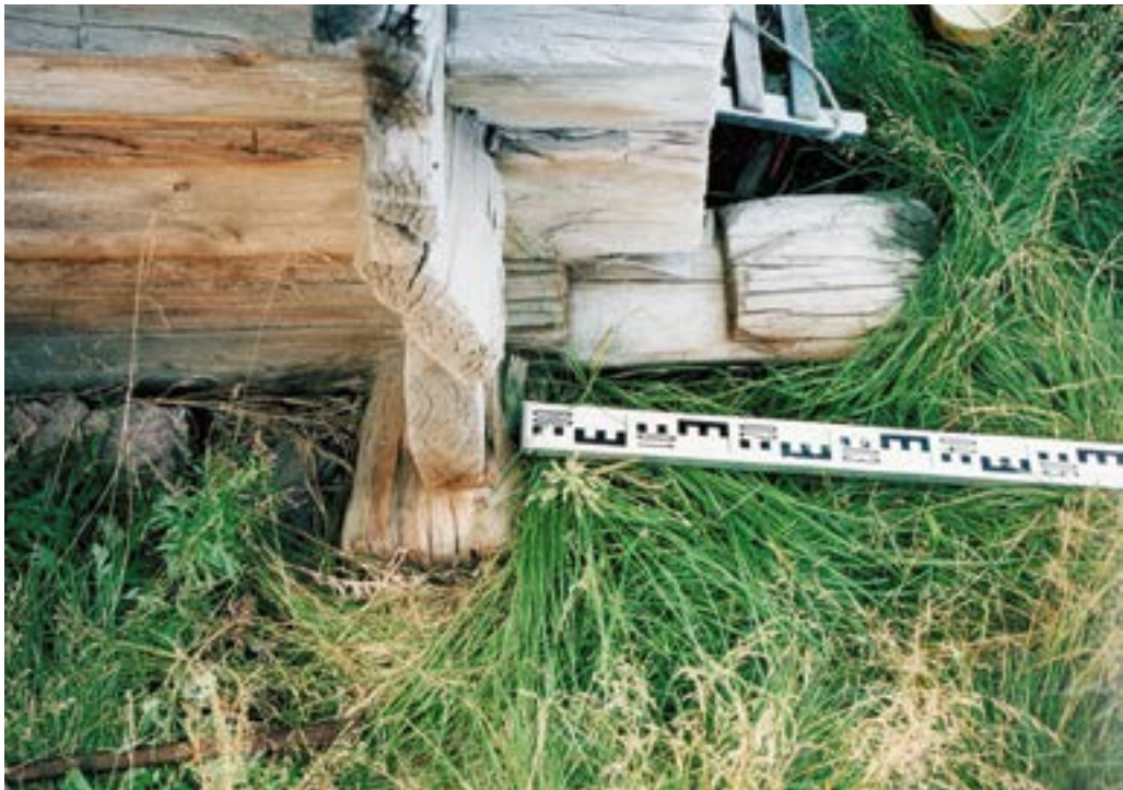
Рис. 56. Пос. Горноknязевск Приуральского района ЯНАО. Летний жилой дом Е.Н. Тайшиной. Фрагмент южного фасада. Окладные венцы. Fig. 56. Gornoknyazevsk settlement, Priural district of the Yamal-Nenets Autonomous Okrug. Summer residential building of E. N. Tayshina. The southern facade. Sole timbers
