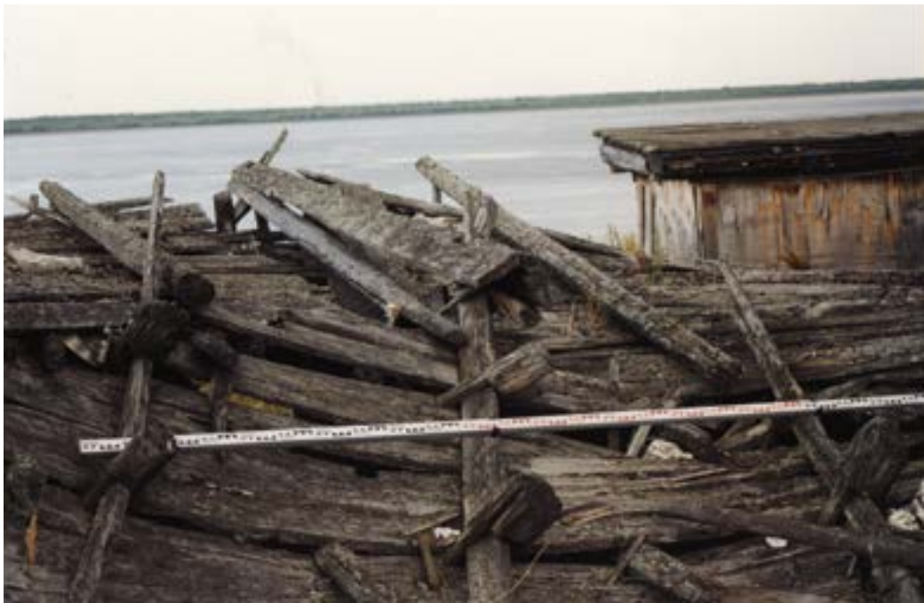
Рис. 120. Пос. Горноknязевск Приуральского района ЯНАО. Хозяйственный амбар Е.Н. Тайшиной. Фрагмент юго-западного фасада. Фрагмент фронтовой части. Узлы крепления стоек каркаса деревянными вкладышами к стеновому ограждению. Конструкция конька. Охлупень. Гнеты. Fig. 120. Gornoknyazevsk settlement, Priural district of the Yamal-Nenets Autonomous Okrug. Household barn of E. N. Tayshina. Southwestern wall. Fragment of the pediment. Knots for attaching frame posts with wooden inserts to the wall fencing. Ridge design.
