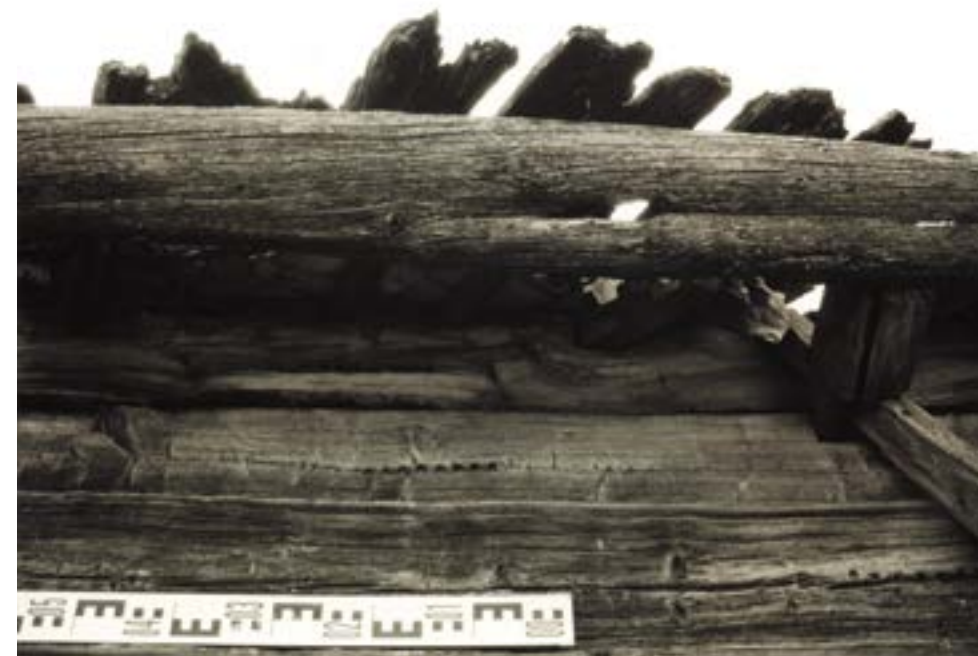
Рис. 127. Пос. Горноknязевск Приуральского района ЯНАО. Хозяйственный амбар Е.Н. Тайшиной. Фрагмент северо-западного фасада. Врезка кровельной обрешетки в плаху верхнего венца. Врубка курицы (сломана), поддерживающей поток. Фрагмент потока
