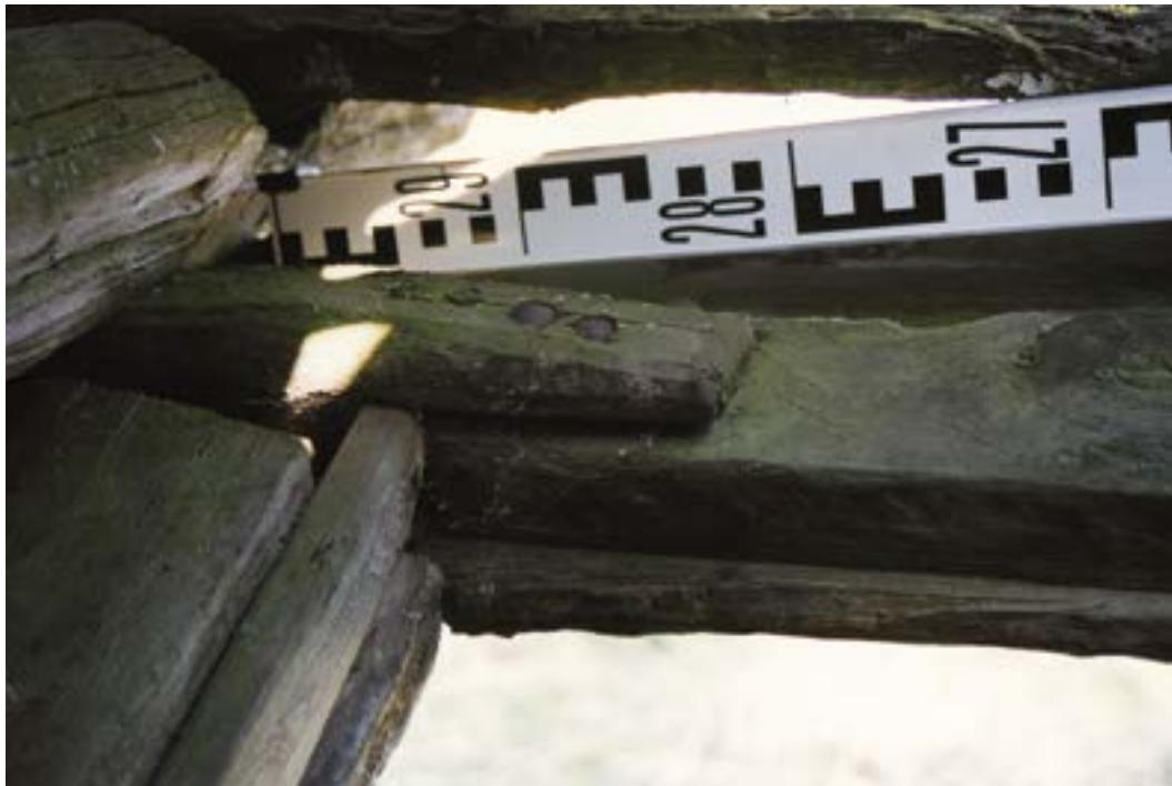
Рис. 104. Пос. Горнокнязевск Приуральского района ЯНАО. Хозяйственный амбар Е.Н. Тайшиной. Фрагмент северо-восточной стены. Конструкция дверного блока. Верхний узел беспетельного открывания двери (вид из интерьера). Fig. 104. Gornoknyazevsk settlement, Priural district of the Yamal-Nenets Autonomous Okrug. Household barn of E. N. Tayshina. Northeastern wall. Door block construction. Upper hingeless door opener (view from the interior).
