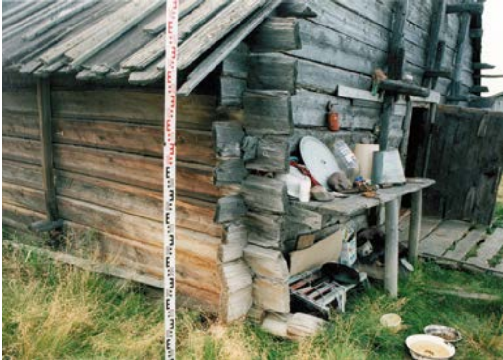
Рис. 55. Пос. Горноknязевск Приуральского района ЯНАО. Летний жилой дом Е.Н. Тайшиной. Вид с юго-восточного угла. Врубка стеновых плах. Определение свеса кровли относительно уровня земли. Стол-посудник. Fig. 55. Gornoknyazevsk settlement, Priural district of the Yamal-Nenets Autonomous Okrug. Summer residential building of E. N. Tayshina. View from the southeastern corner. Cutting wall blocks. Determination of roof overhang relative to ground level. Dish table.
