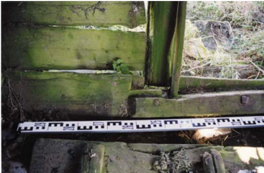
Рис. 103. Пос. Горноknязевск Приуральского района ЯНАО. Хозяйственный амбар Е.Н. Тайшиной. Фрагмент северо-восточной стены. Конструкция дверного блока. Нижний узел беспетельного открывания двери (вид из интерьера). Fig. 103. Gornoknyazevsk settlement, Priural district of the Yamal-Nenets Autonomous Okrug. Household barn of E. N. Tayshina. Northeastern wall. Door block construction. Lower hingeless door opener (view from the interior).
