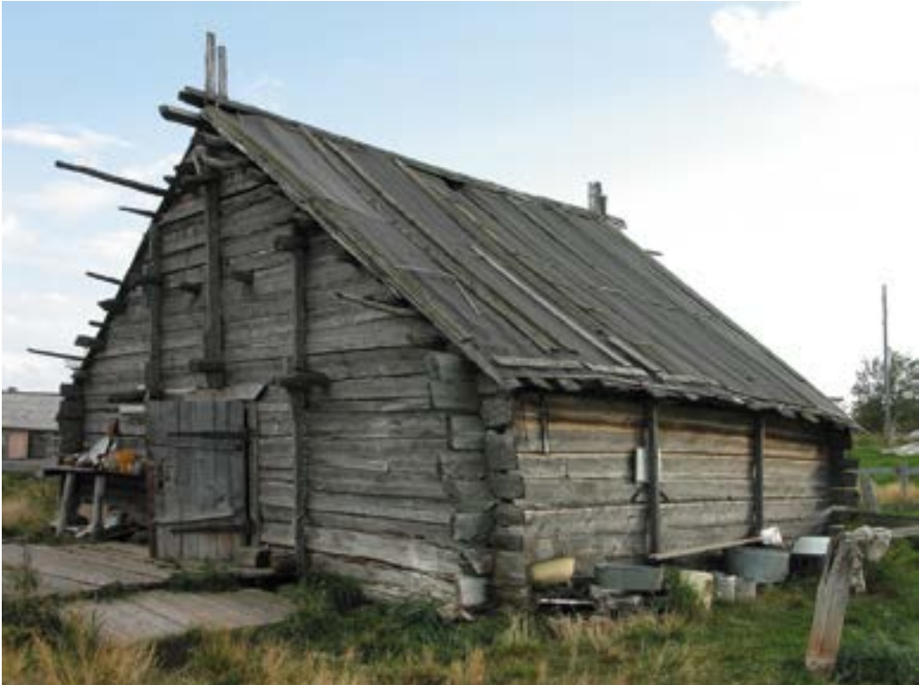
Рис. 41. Пос. Горноknязевск Приуральского района ЯНАО. Летний жилой дом Е.Н. Тайшиной. Вид с северо-востока. Fig. 41. Gornoknyazevsk settlement, Priural district of the Yamal-Nenets Autonomous Okrug. Summer residential building of E. N. Tayshina. View from the north-east
