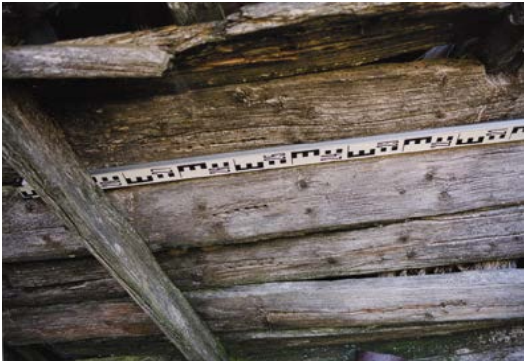
Рис. 115. Пос. Горнокнязевск Приуральского района ЯНАО. Хозяйственный амбар Е.Н. Тайшиной. Фрагмент северо-восточного фасада. Маркировка венцов (плах) высверленными отверстиями (количественное увеличение – снизу вверх). Fig. 115. Gornoknyazevsk settlement, Priural district of the Yamal-Nenets Autonomous Okrug. Household barn of E. N. Tayshina. Northeastern wall. Marking of blocks with drilled holes (quantitative increase - from bottom to top).
