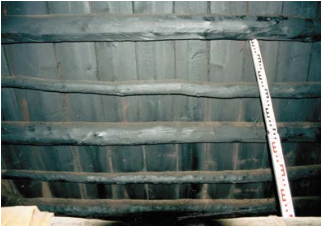
Рис. 77 Пос. Горноknязевск Приуральского района ЯНАО. Летний жилой дом Е.Н. Тайшиной. Интерьер. Вид на южный свес кровли. Устройство кровли по слегам. Fig. 77. Gornoknyazevsk settlement, Priural district of the Yamal-Nenets Autonomous Okrug. Summer residential building of E. N. Tayshina. Interior. View on the southern part of roof. Roof system with poles.
