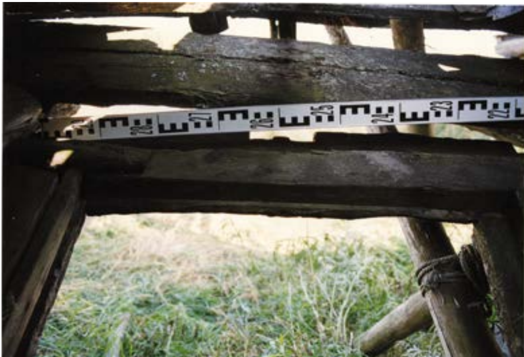
Рис. 106. Пос. Горнокнязевск Приуральского района ЯНАО. Хозяйственный амбар Е.Н. Тайшиной. Фрагмент северо-восточной стены. Конструкция дверного блока с неполной дверной коробкой, верхник отсутствует. Четверть выбрана в плаше стенового ограждения (вид из интерьера). Fig. 106. Gornoknyazevsk settlement, Priural district of the Yamal-Nenets Autonomous Okrug. Household barn of E. N. Tayshina. Northeastern wall. Door block construction with an incomplete door frame, the top is missing (view from the interior).
