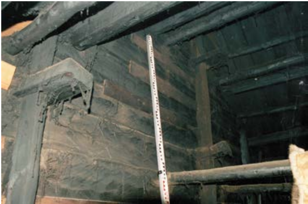
Рис. 89 Пос. Горноknязевск Приуральского района ЯНАО. Летний жилой дом Е.Н. Тайшиной. Интерьер. Фрагмент западной стены. Узлы крепления стоек каркаса к стеновой конструкции (верхний ярус). Новые прибивные нащельники на плахах фронтона. Fig. 89. Gornoknyazevsk settlement, Priural district of the Yamal-Nenets Autonomous Okrug. Summer residential building of E. N. Tayshina. Interior. The western wall. Connections for attaching frame posts to the wall structure (upper tier). New nailed strips on the gable blocks.
