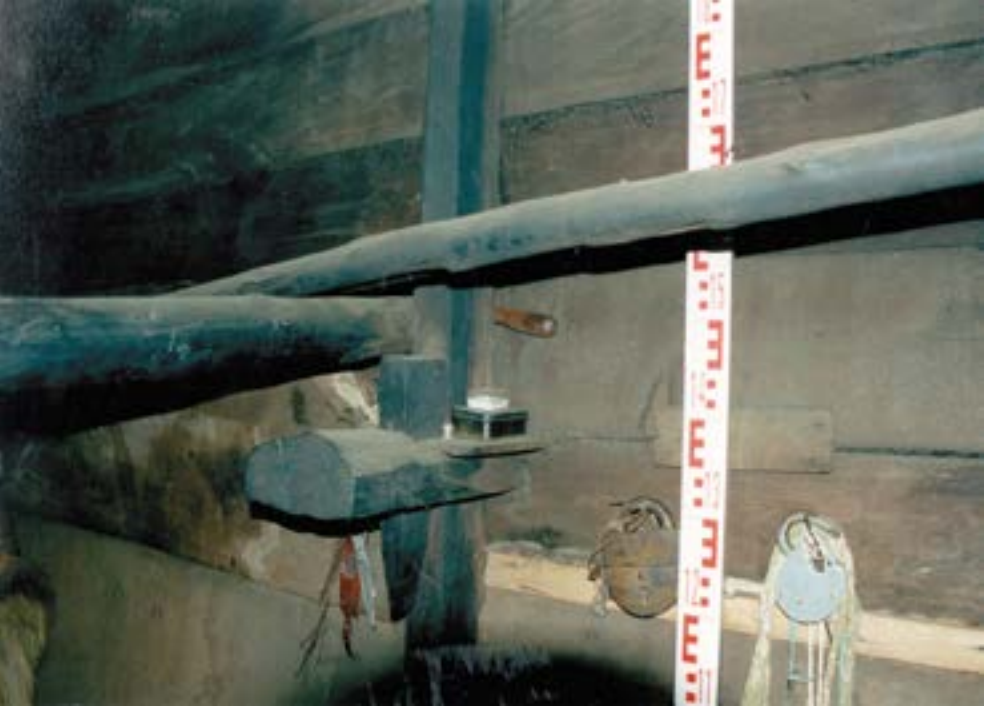
Рис. 71. Пос. Горноknязевск Приуральского района ЯНАО. Летний жилой дом Е.Н. Тайшиной. Интерьер. Фрагмент восточной стены. Узел крепления стойки каркаса к стеновой конструкции (средний ярус). Система вешал. Fig. 71. Gornoknyazevsk settlement, Priural district of the Yamal-Nenets Autonomous Okrug. Summer residential building of E. N. Tayshina. Interior. The eastern wall. Mounting unit for the frame post to the wall structure (middle tier). The hangers' system. Drywall covering.
