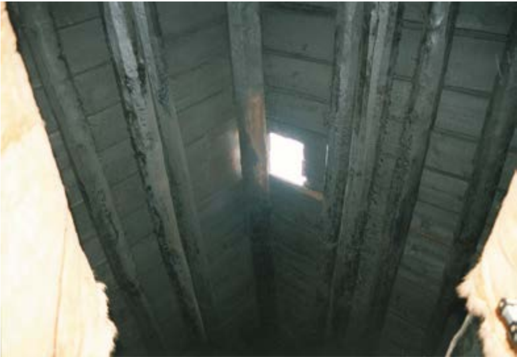
Рис. 78 Пос. Горноknязевск Приуральского района ЯНАО. Летний жилой дом Е.Н. Тайшиной. Интерьер. Отверстие для выхода дыма в коньковой части кровли. Fig. 78. Gornoknyazevsk settlement, Priural district of the Yamal-Nenets Autonomous Okrug. Summer residential building of E. N. Tayshina. Interior. The smoke exit in the ridge part of the roof.
