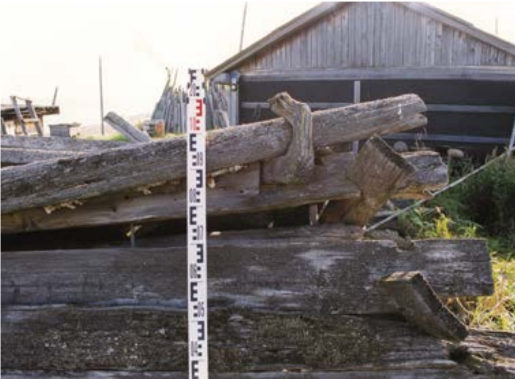
Рис. 130. Пос. Горнокнязевск Приуральского района ЯНАО. Хозяйственный амбар Е.Н. Тайшиной. Фрагмент северо-западного фасада. Фрагмент потока. Врубка курицы, поддерживающей поток. Fig. 130. Gornoknyazevsk settlement, Priural district of the Yamal-Nenets Autonomous Okrug. Household barn of E. N. Tayshina. Northwestern wall construction.
