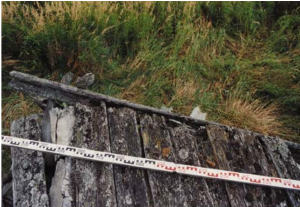
Рис. 140. Пос. Горноknязевск Приуральского района ЯНАО. Хозяйственный амбар Е.Н.Тайшиной. Конструкция кровли. Колотые доски теса. Фрагмент потока северо-западного фасада. Fig. 140. Gornoknyazevsk settlement, Priural district of the Yamal-Nenets Autonomous Okrug. Household barn of E. N. Tayshina. Roof structure. Northwestern facade
