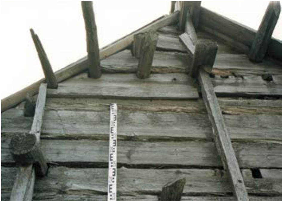
Рис. 51. Пос. Горноknязевск Приуральского района ЯНАО. Летний жилой дом Е.Н. Тайшиной. Фрагмент восточного фасада. Фрагмент фронтона. Узел крепления левой и центральной стоек каркаса к стеновой конструкции (верхний ярус). Пазы от первоначального крепления к стеновой конструкции вкладышей, фиксирующих стойки. Fig. 51. Gornoknyazevsk settlement, Priural district of the Yamal-Nenets Autonomous Okrug. Summer residential building of E. N. Tayshina. The eastern facade. Pediment fragment. Mounting unit for the left and central pillars of the frame to the wall structure (top tier). Grooves from the initial attachment to the wall structure of the liners securing the posts.
