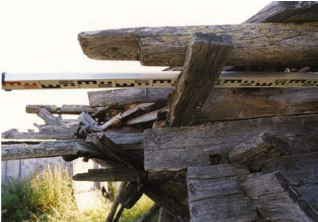
Рис. 128. Пос. Горнокнязевск Приуральского района ЯНАО. Хозяйственный амбар Е.Н. Тайшиной. Фрагмент северо-западного фасада. Фрагмент потока, декоративная обработка потока (вид сбоку). Fig. 128. Gornoknyazevsk settlement, Priural district of the Yamal-Nenets Autonomous Okrug. Household barn of E. N. Tayshina. Northwestern wall construction (view from side)
