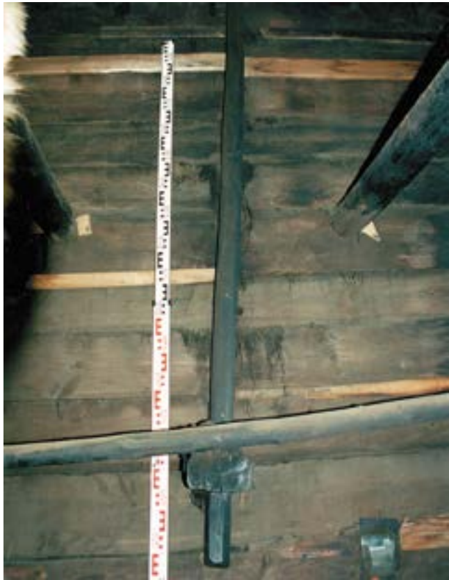
Рис. 74. Пос. Горноknязевск Приуральского района ЯНАО. Летний жилой дом Е.Н. Тайшиной. Интерьер. Фрагмент восточной стены. Центральная стойка каркаса. Система вешал. Fig. 74. Gornoknyazevsk settlement, Priural district of the Yamal-Nenets Autonomous Okrug. Summer residential building of E. N. Tayshina. Interior. The eastern wall. Central frame post. The hangers' system.
