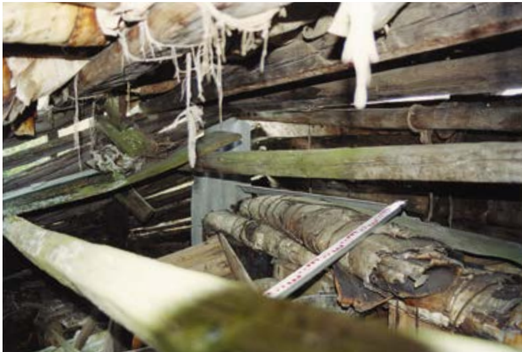
Рис. 141. Пос. Горноknязевск Приуральского района ЯНАО. Хозяйственный амбар Е.Н.Тайшиной. Интерьер. Вид на западный угол. Система вешал. Традиционная полка, опирающаяся на вешала и располагающаяся вдоль юго-западной (торцевой) стены. Свернутый в рулон берестяной гидроизоляционный ковер. Fig. 141. Gornoknyazevsk settlement, Priural district of the Yamal-Nenets Autonomous Okrug. Household barn of E. N. Tayshina. Interior. View to the western corner. The hangers' system. A traditional shelf supported by hangers and located along the south western wall. Rolled birch bark waterproofing carpet.
