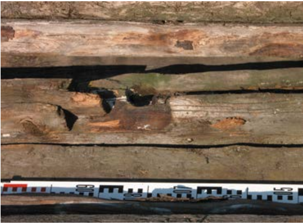
Рис. 145. Пос. Горнокнязевск Приуральского района ЯНАО. Хозяйственный амбар Е.Н. Тайшиной. Конструктивные особенности Fig. 145. Gornoknyazevsk settlement, Priural district of the Yamal-Nenets Autonomous Okrug. Household barn of E. N. Tayshina. Construction features
