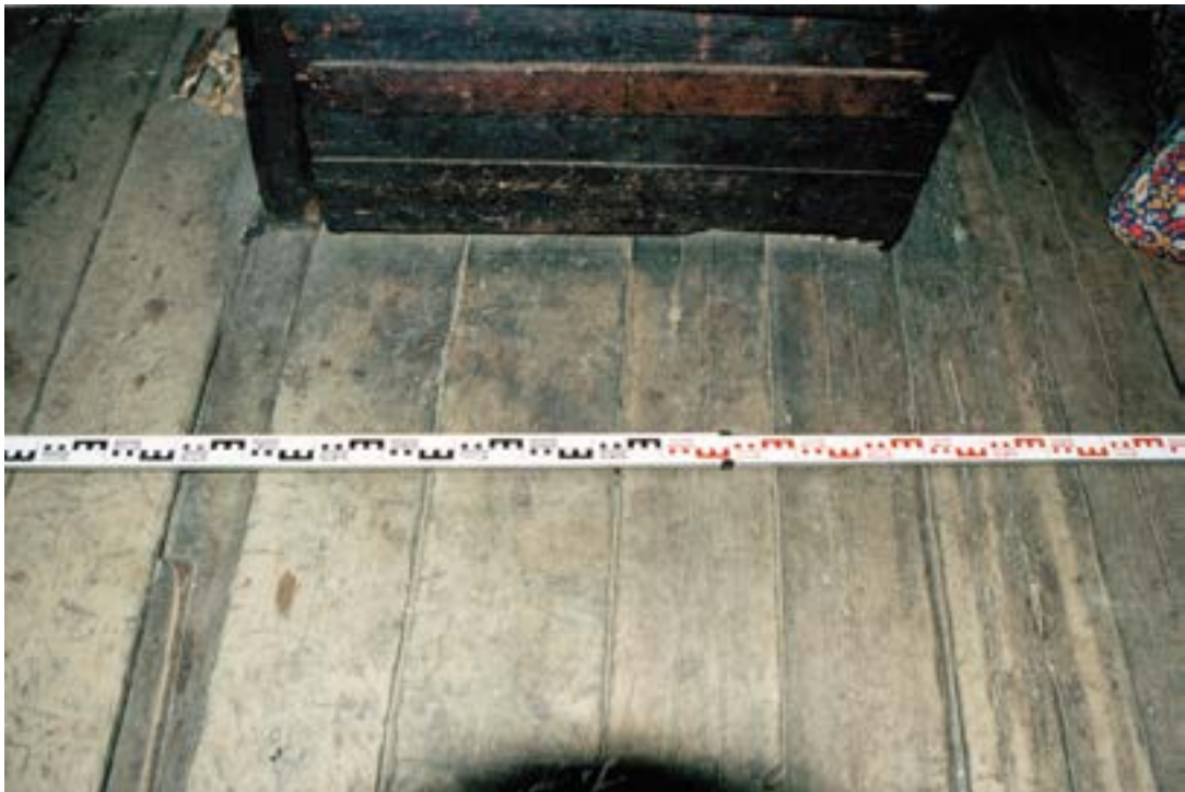
Рис. 84. Пос. Горноknязевск Приуральского района ЯНАО. Летний жилой дом Е.Н. Тайшиной. Интерьер. Дощатое покрытие пола. Fig. 84. Gornoknyazevsk settlement, Priural district of the Yamal-Nenets Autonomous Okrug. Summer residential building of E. N. Tayshina. Interior. Plank flooring.
